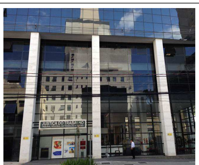
Figura 02: Fachada antes da substituição das esquadrias.
