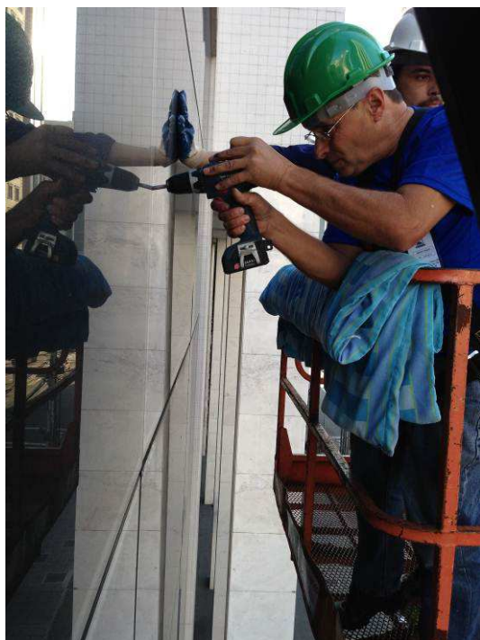
Figura 13: Detalhe da retirada de parafusos de esquadria existente.
