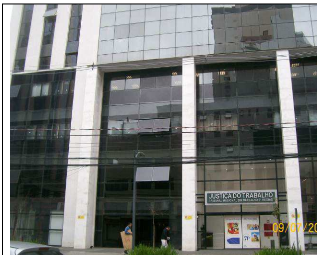
Figura 23: Vista da fachada, após a substituição das esquadrias.
