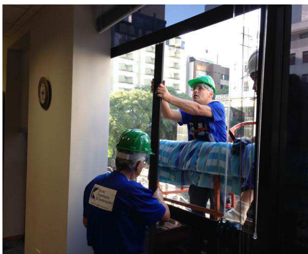
Figura 17: Montagem de montante de esquadria.
