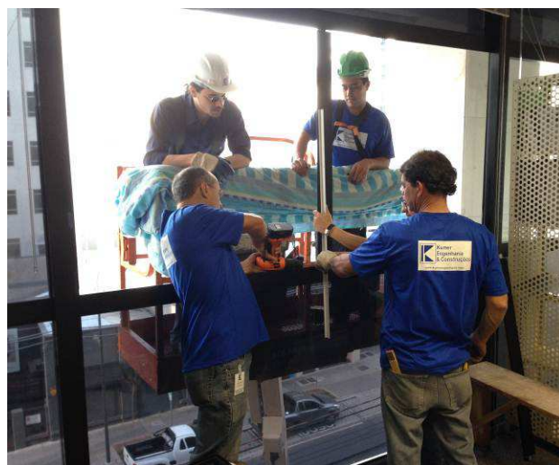
Figura 18: Montagem de montante de esquadria.
