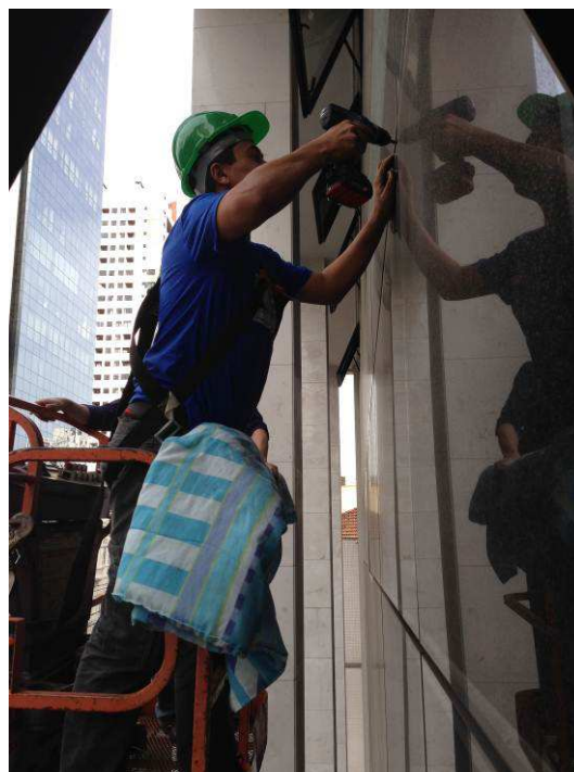
Figura 14: Detalhe da retirada de parafusos de esquadria existente.
