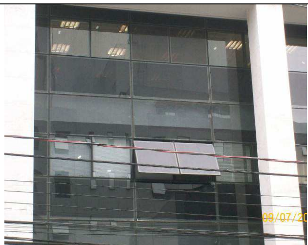
Figura 26: Detalhe das esquadrias substituídas.
