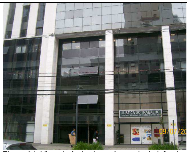
Figura 24: Vista da fachada, após a substituição das esquadrias.
