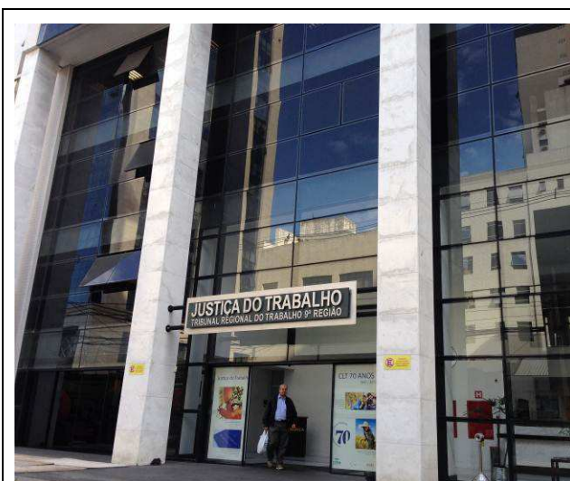
Figura 01: Fachada antes da substituição das esquadrias.
