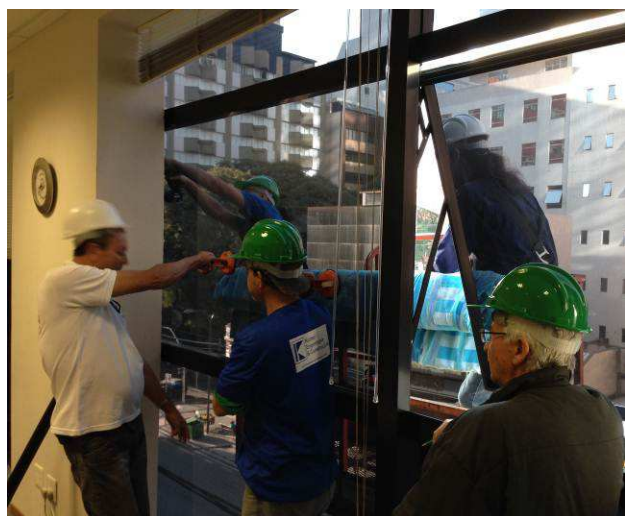
Figura 15: Preparação para retirada de esquadria.
