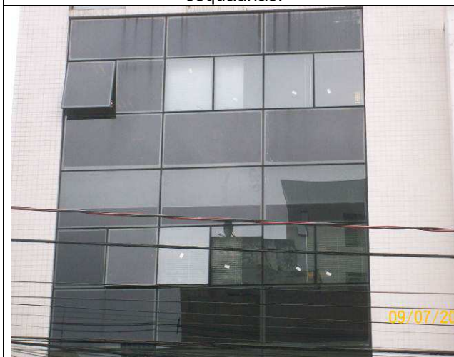
Figura 25: Detalhe das esquadrias substituídas.
