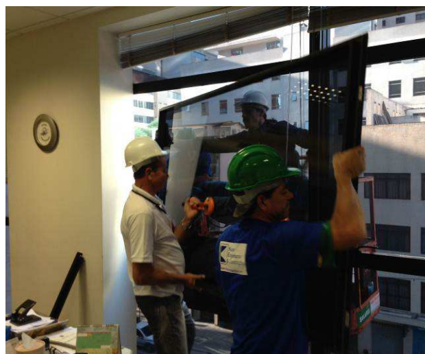
Figura 16: Retirada de esquadria.
