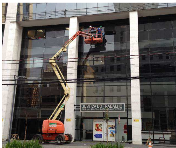
Figura 12: Retirada de esquadrais no vão central.
