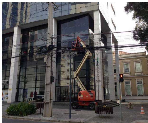
Figura 19: Plataforma elevatória posicionada no canto direito da fachada.
