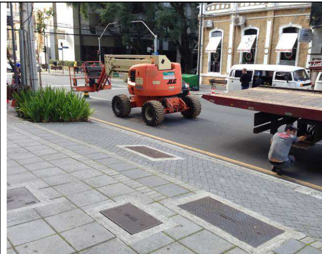
Figura 07: Transporte e recebimento da plataforma elevatória utilizada.
