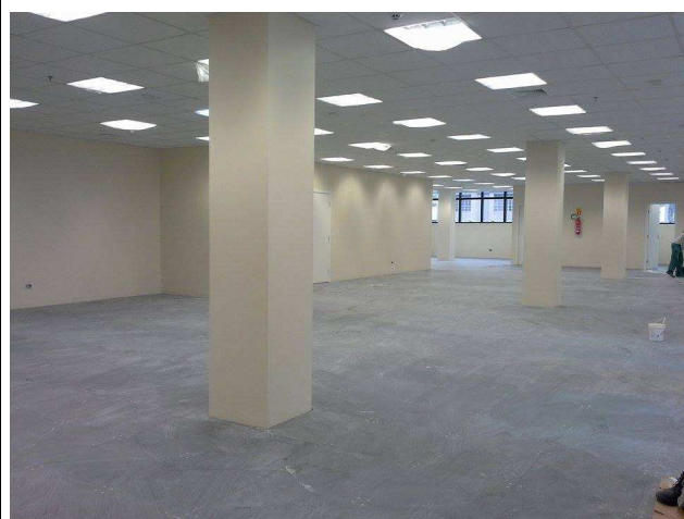
Figura 06: divisórias em gesso acartonado.
