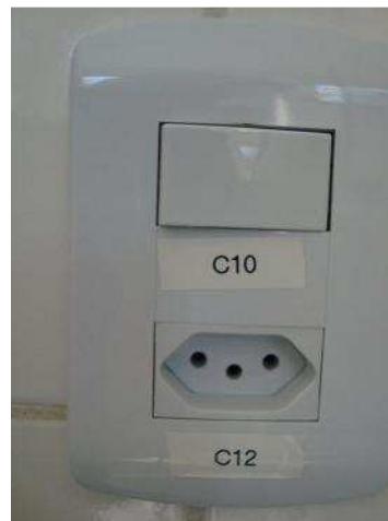
Circuitos identificados por anilhas nos cabos e etiquetas no espelho
