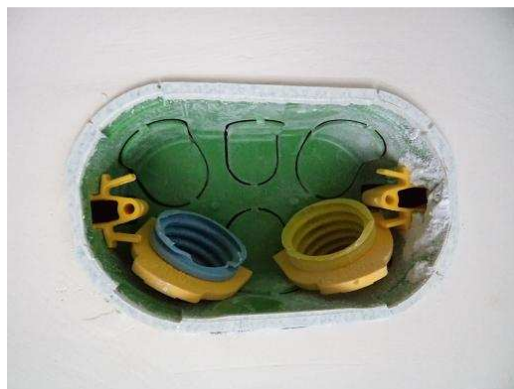
Caixas embutidas em alvenaria e dry-wall
