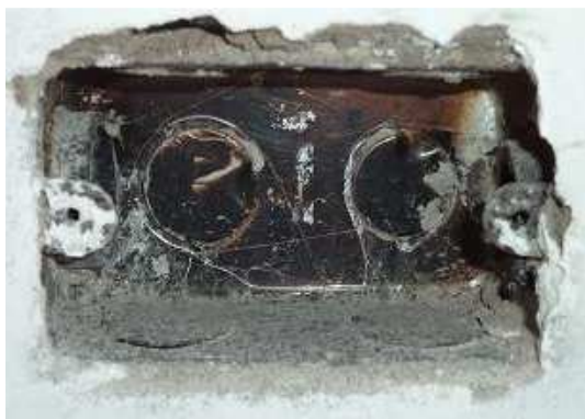
Caixas embutidas em alvenaria e dry-wall
