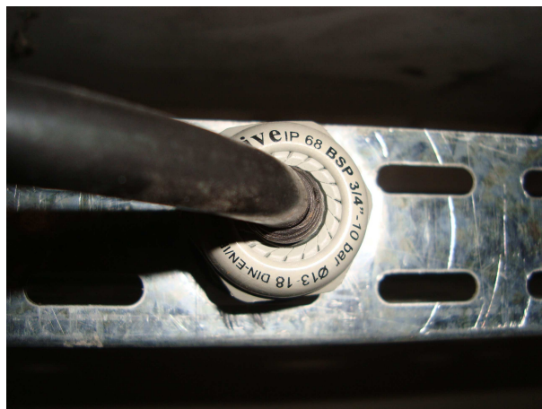
Prensa-cabos (derivações para as luminárias)
