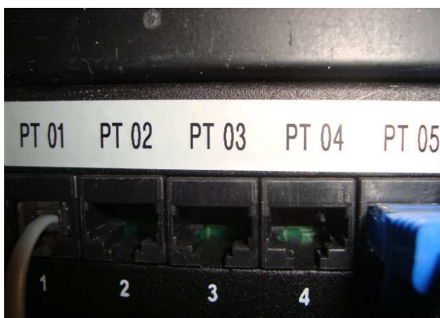
Circuito identificado por etiqueta no patch pannel
