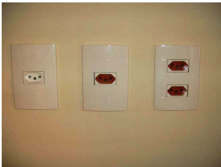
Tomadas com miolos branco (energia comum) e vermelho (energia estabilizada)
