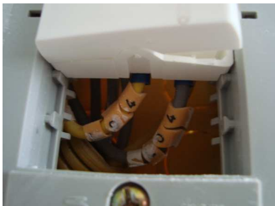
Circuitos identificados por anilhas nos cabos e etiquetas no espelho
