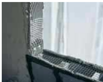
Ligação da Estrutura com a Alvenaria
