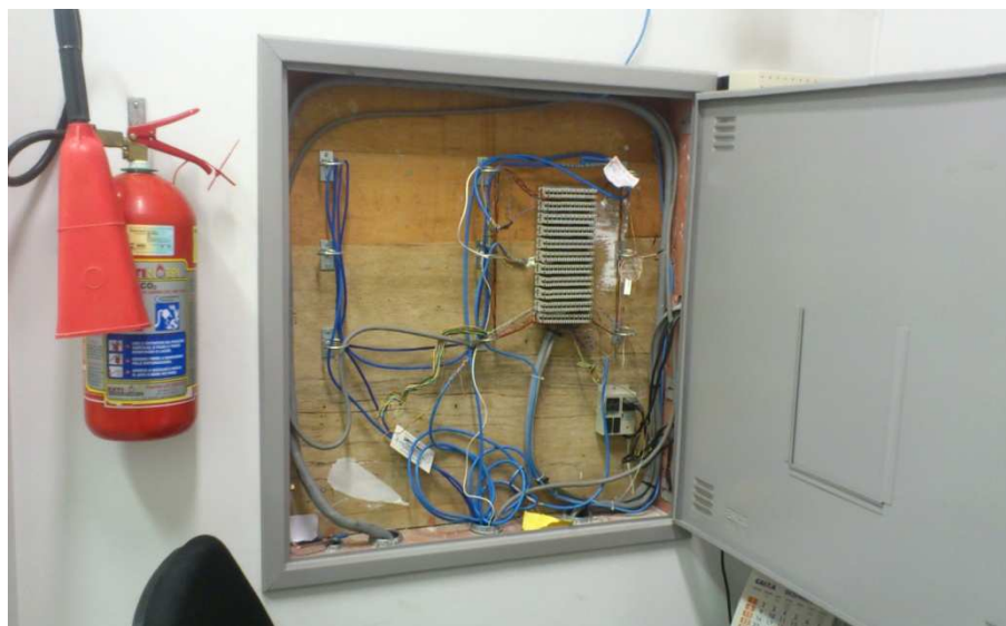
Figura 16 – DG a ser remanejado
