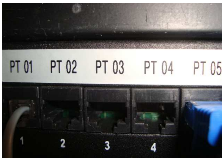
Figura 21 – Patch panel com identificação de pontos
