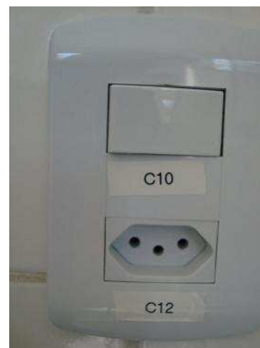
Figura 6 - Identificação de condutores, tomadas e interruptores
