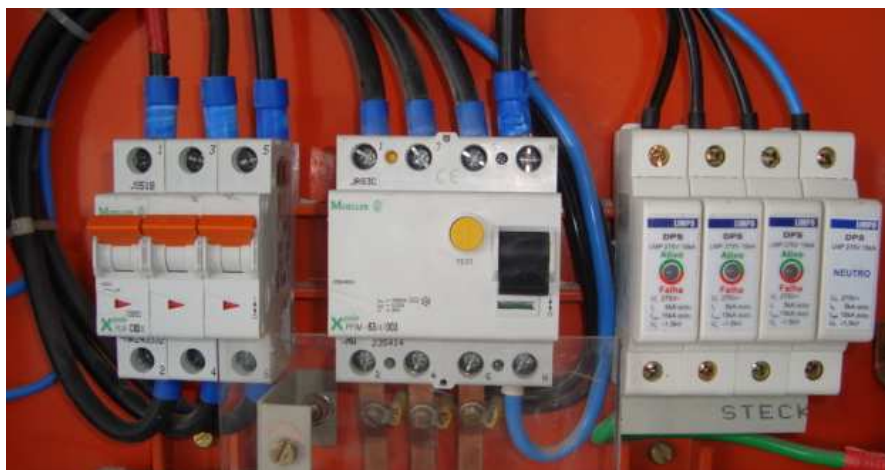
Figura 5 – Exemplo (disjuntor, dispositivo DR e DPS em quadro)
