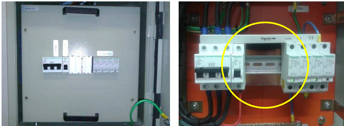
Figura 4 – Quadro elétrico QDE-Auxiliar atual (Em destaque o espaço reserva para ampliação)
