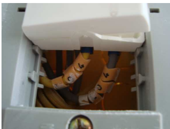
Figura 6 - Identificação de condutores, tomadas e interruptores
