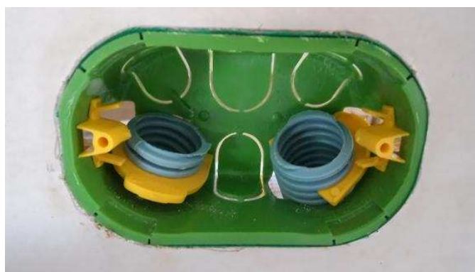
Figura 2 – Caixa de ligação para drywall
