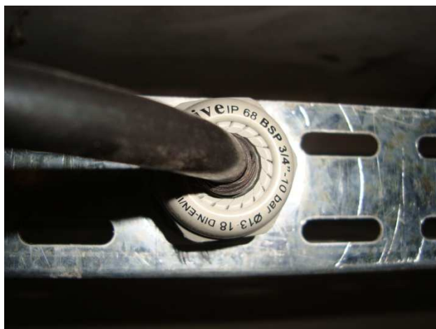
Figura 9 – Derivação para luminárias (prensa-cabo e plug)
