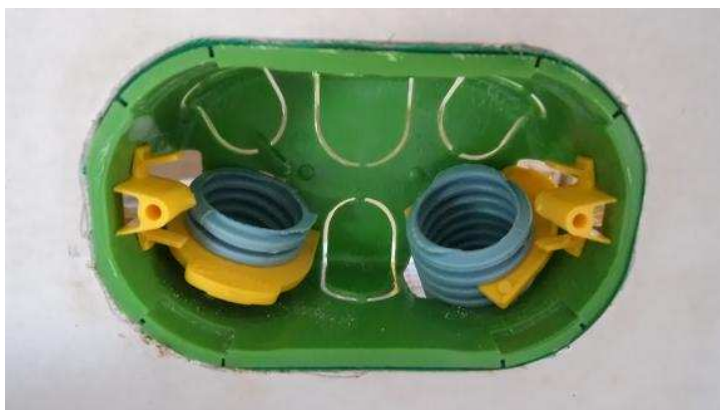
Figura 26 – Caixa de ligação para drywall
