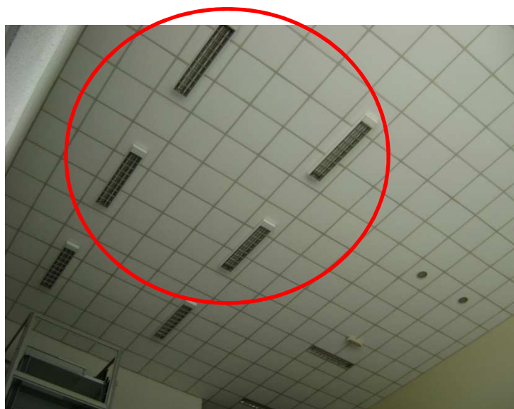
Figura 14 – Luminárias do hall que deverão ser retiradas
