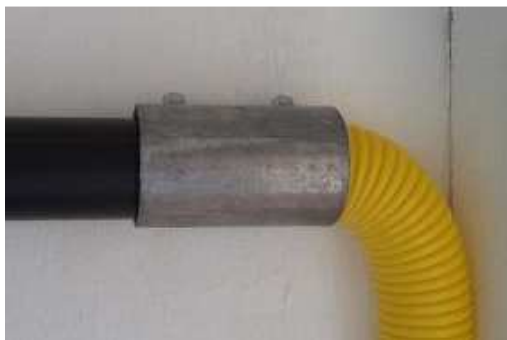
Figura 1 – Transição de eletroduto rígido para corrugado
