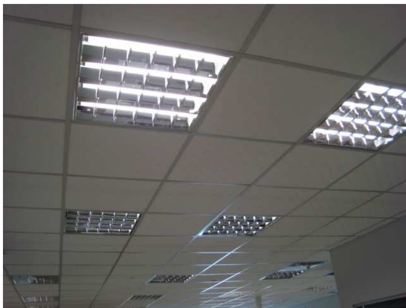
Figura 10 – Luminárias embutidas 4x16 W
