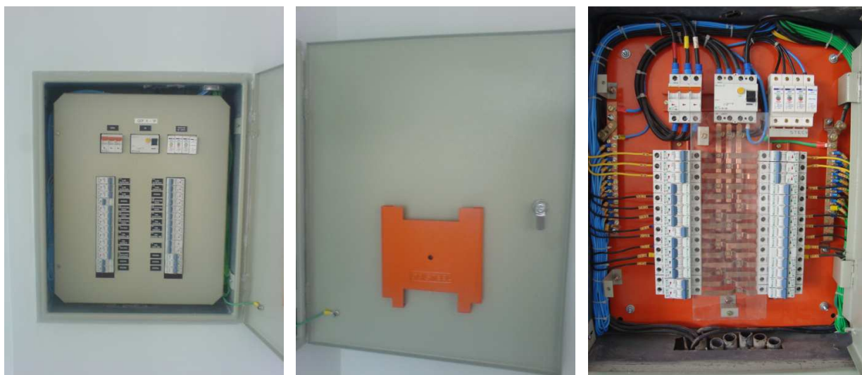
Figura 3 – Quadro elétrico (exemplo)
