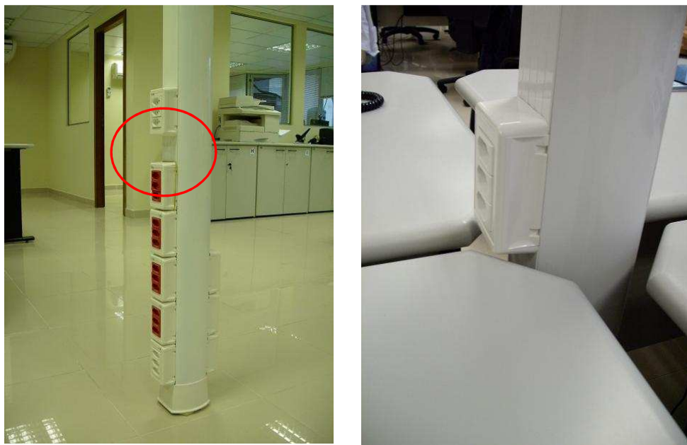
Figura 7 – Poste técnico (Observar interrupção dos porta equipamentos para encaixe da mesa)
