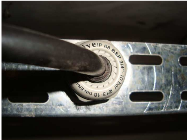
Figura 9 – Derivação para luminárias (prensa-cabo e plug)
