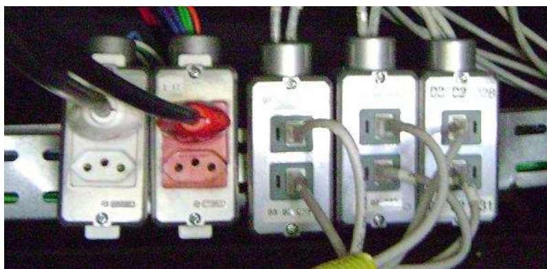
Figura 7 – Padrão genérico (tomadas sobre o forro)
