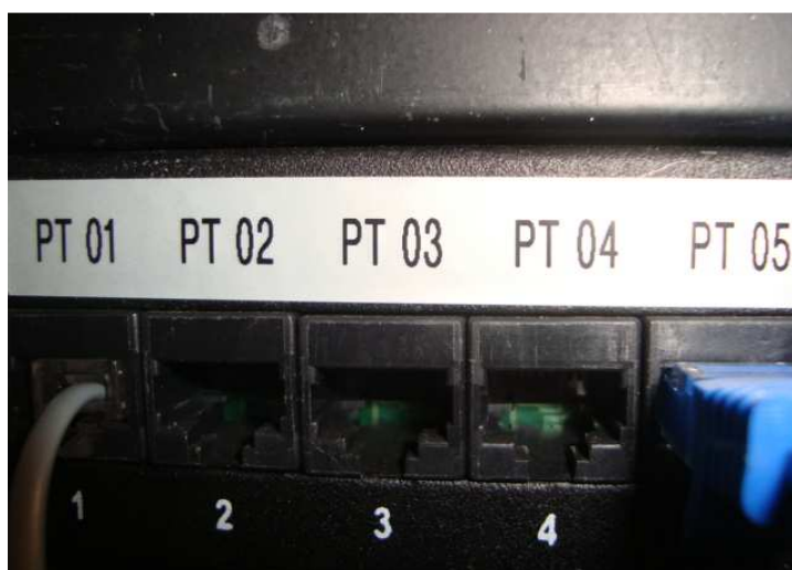
Figura 16 – Patch panel com identificação de pontos
