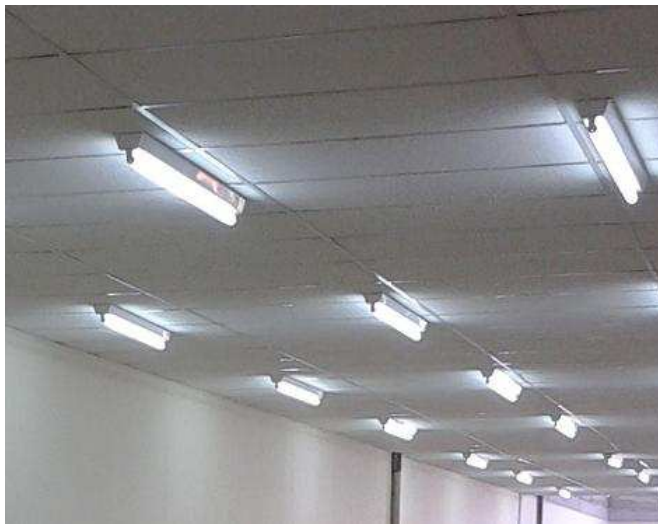
Figura 12 – Luminárias comercial 1x32 W
