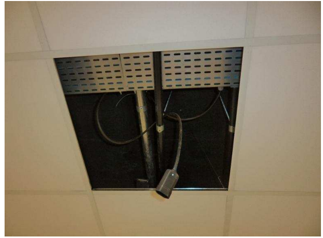
Figura 9 – Derivação para luminárias (prensa-cabo e plug)
