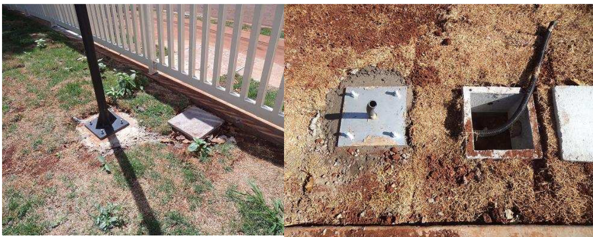
Figura 15 – Base para fixação das luminárias externas
