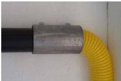
Figura 1 – Transição de eletroduto rígido para corrugado
