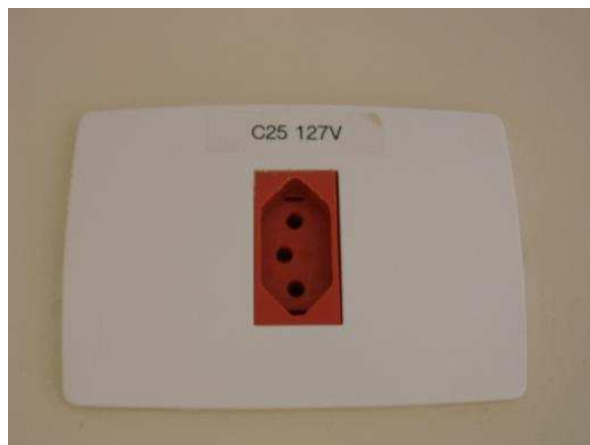
Figura 8 – Tomadas comum e estabilizada
