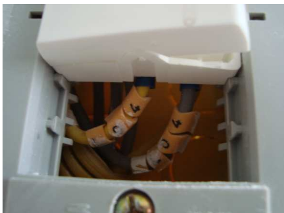
Figura 5 - Identificação de condutores, tomadas e interruptores
