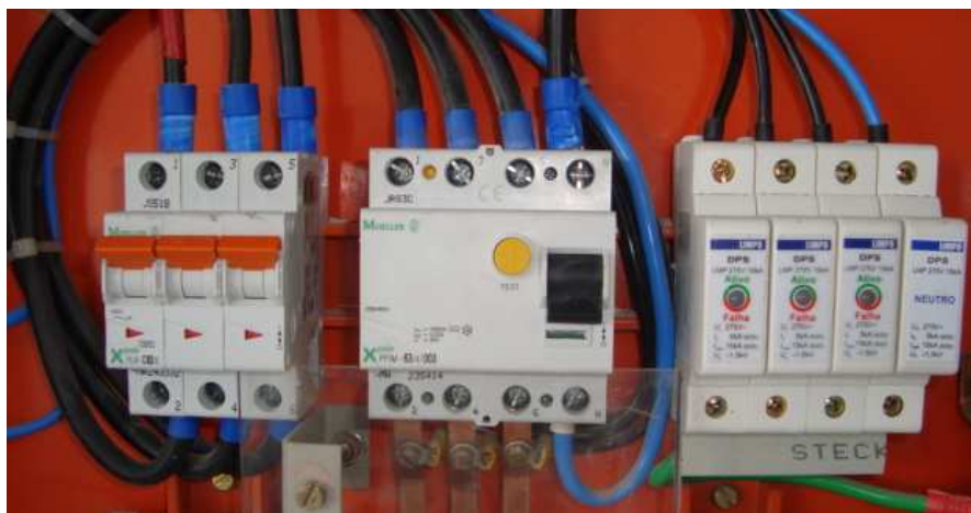
Figura 4 – Disjuntor, dispositivo DR e DPS em quadro
