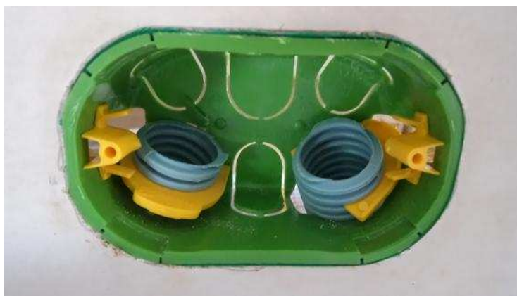
Figura 2 – Caixa de ligação em drywall
