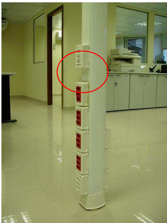
Figura 6 – Poste técnico (Observar interrupção dos porta equipamentos para encaixe da mesa)
