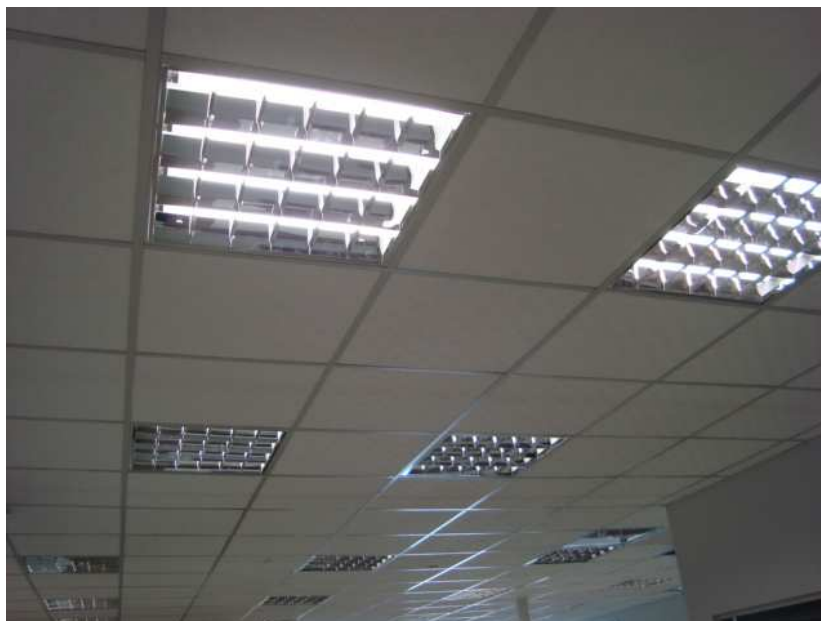
Figura 10 – Luminárias embutidas 4x16 W
