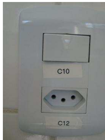
Figura 5 - Identificação de condutores, tomadas e interruptores
