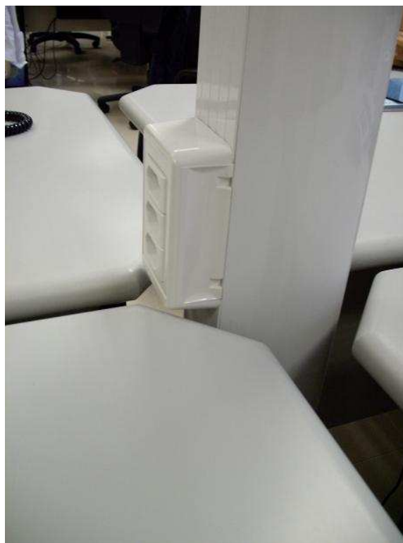
Figura 6 – Poste técnico (Observar interrupção dos porta equipamentos para encaixe da mesa)
