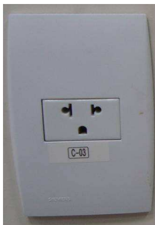
Circuito identificado por etiqueta no espelho da tomada
