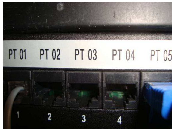
Circuito identificado por etiqueta no patch pannel
