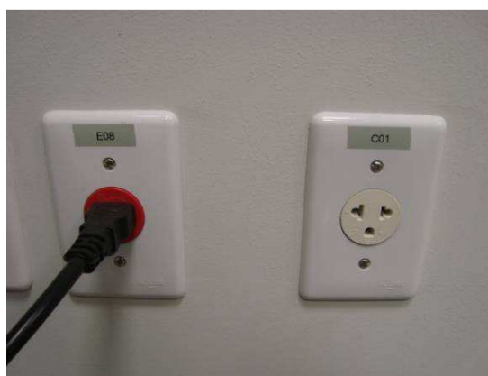
Circuito identificado por anilhas nos cabos e etiqueta no espelho
