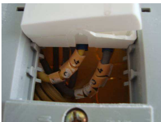
Circuito identificado por anilhas nos cabos e etiqueta no espelho
