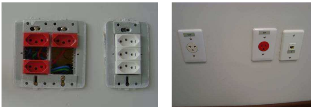
Tomadas com miolo branco (energia comum) e com miolo vermelho (de informática)
