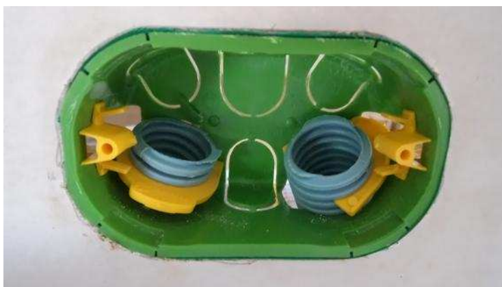
Figura 2 – Caixa de ligação em drywall
