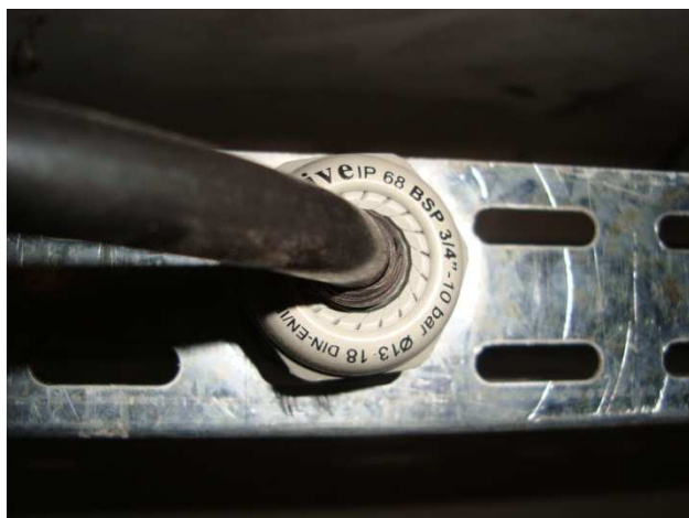
Figura 8 – Derivação para luminárias (prensa-cabo e plug)
