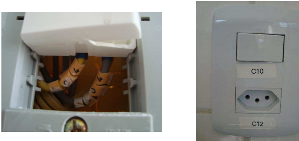
Figura 5 - Identificação de condutores, tomadas e interruptores
