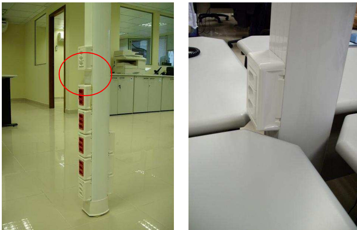
Figura 6 – Poste técnico (Observar interrupção dos porta equipamentos para encaixe da mesa)
