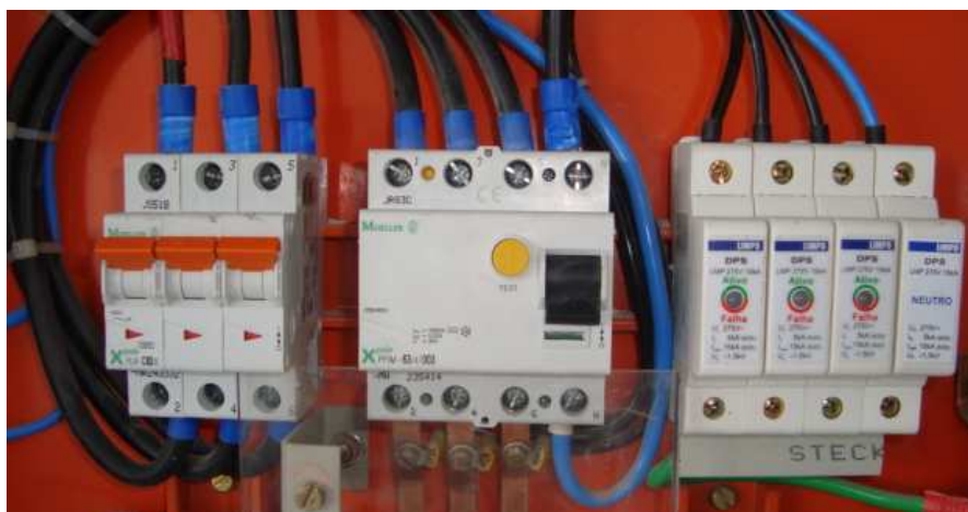
Figura 4 – Disjuntor, dispositivo DR e DPS em quadro
