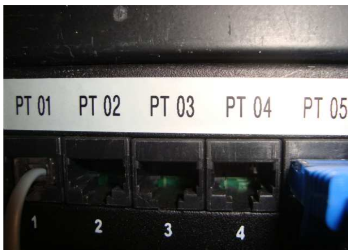
Figura 138 – Patch panel com identificação de pontos
