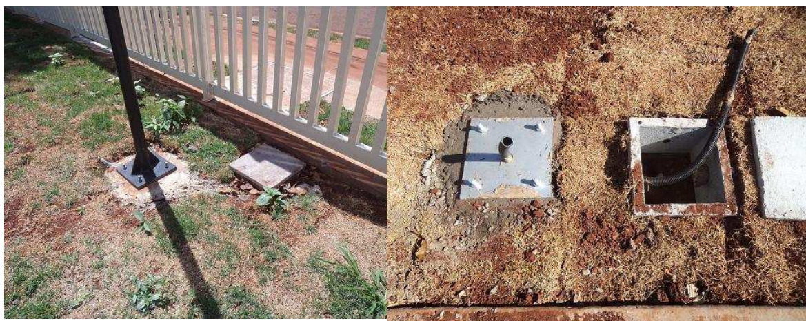
Figura 72 – Base para fixação das luminárias externas
