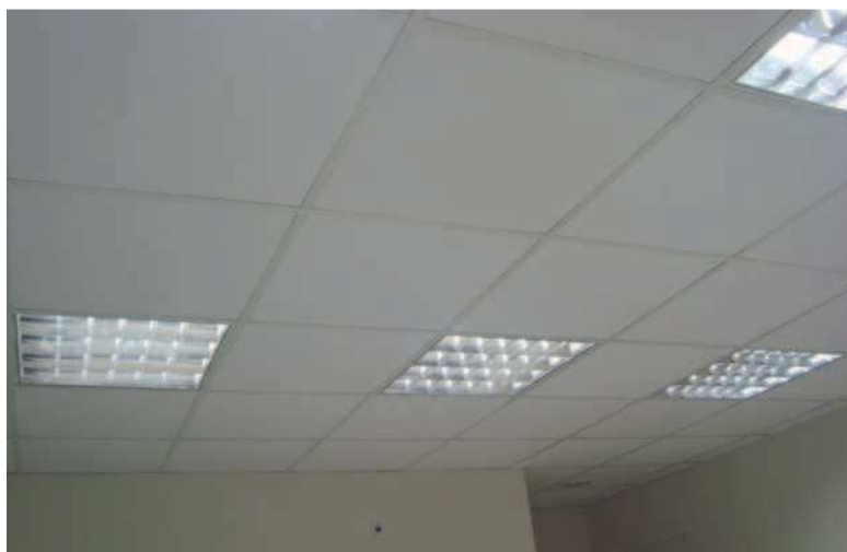
Figura 10 - Luminária 4x16W com aletas em forro modular 62,5 x 62,5cm
