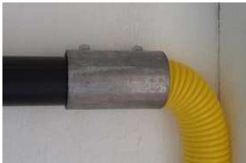
Figura 1 – Transição de eletroduto rígido para corrugado
