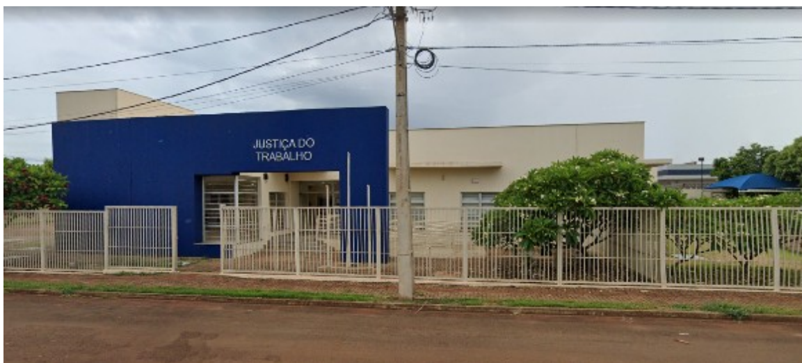
Fachada da Vara do Trabalho de Bandeirantes
