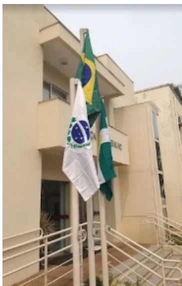
Corrimão escada e rampa
