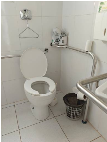
Sanitário acessível unissex
