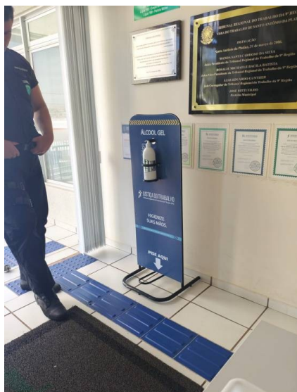
Tapete sobre piso tátil, realocado.
