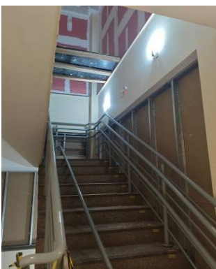
Fechamento da escada em obras
