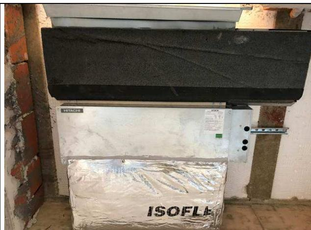
Figura 94C: Evaporadora de 2,0 HP - 1ª Vara.
