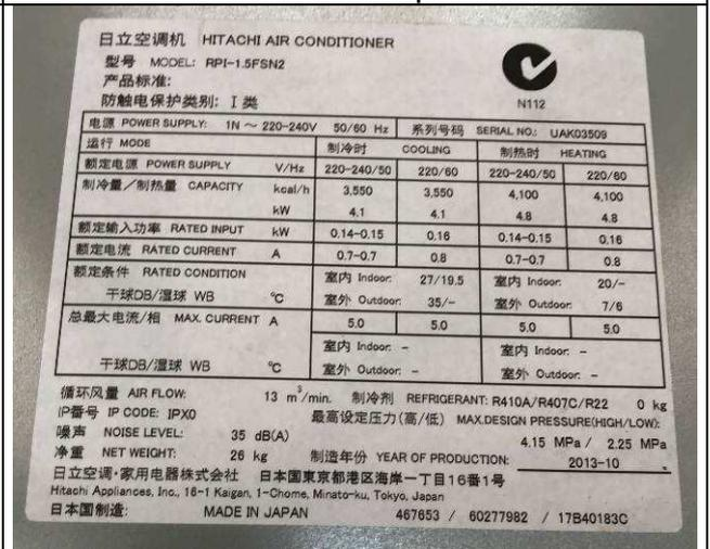
Figura 116C: 1 evaporadora de 1,5 HP - modelo RPI1,5FSN2, da marca Hitachi.
