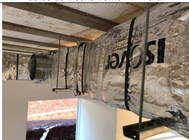
Figura 95C: Dutos de insuflamento com isolamento térmico - 1ª Vara.
