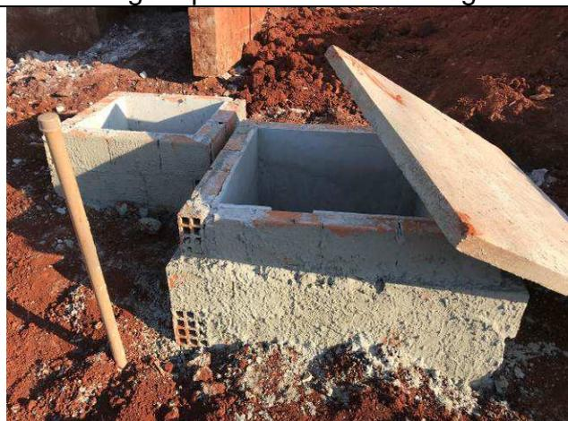
Figura 73C: Caixas de inspeção - rede de drenagem pluvial e coleta de esgoto.
