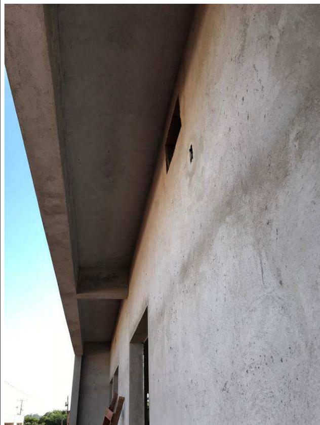
Figura 34C: Revestimento argamassado externo.
