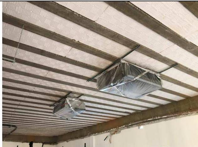
Figura 111C: Evaporadoras de 2,50 HP e 1,00 HP - 3ª Vara.
