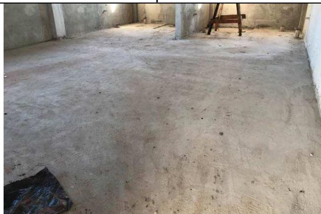
Figura 39C: Contrapiso concretado - Arquivo.
