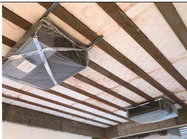
Figura 99C: Evaporadoras de 2,50 HP - 2ª Vara.
