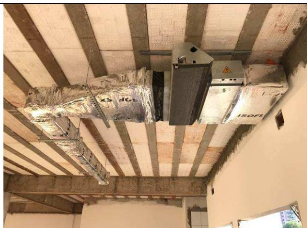
Figura 93C: Evaporadora de 1,00 HP e dutos de insuflamento - 1ª Vara.
