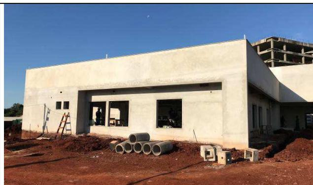
Figura 25C: Revestimento argamassado externo.
