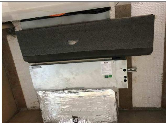
Figura 101C: Evaporadora de 2,00 HP - 2ª Vara.
