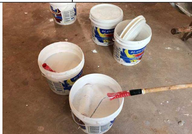
Figura 131C: Emassamento com massa PVA das paredes de alvenaria.
