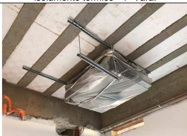
Figura 97C: Evaporadora de 2,50 HP - 2ª Vara.
