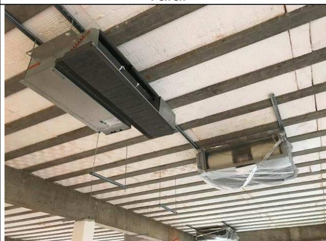
Figura 96C: Evaporadoras de 1,00 HP e 2,50 HP - 2ª Vara.
