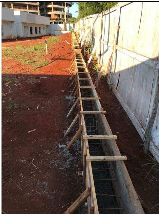
Figura 126C: Formas e armaduras da viga baldrame do gradil de fechamento.
