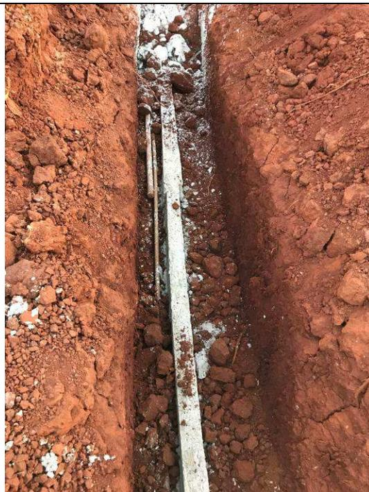
Figura 122C: Tubos externos envelopados da rede prevenção de incêndio.
