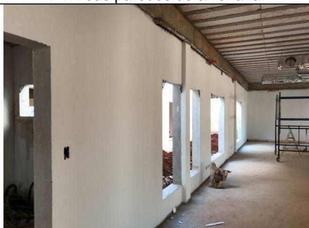
Figura 139C: Emassamento com massa PVA das paredes de alvenaria.
