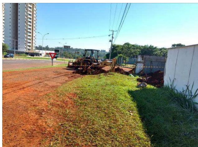
Figura 01C: Abertura de valas para passagem das tubulações - interligação da rede de águas pluviais à galeria pública.
