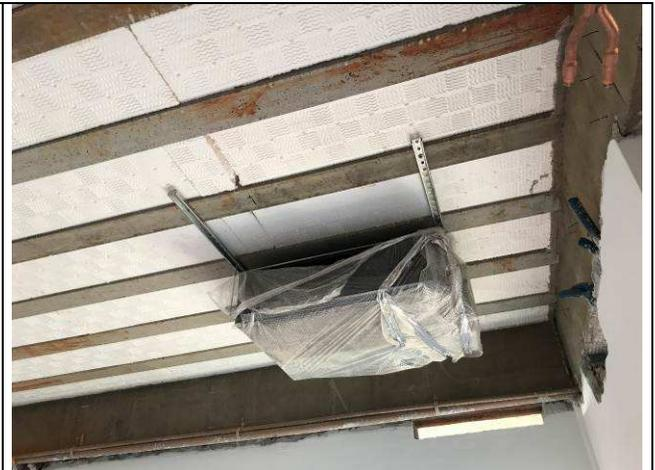
Figura 112C: Evaporadora de 2,50 HP - 3ª Vara.
