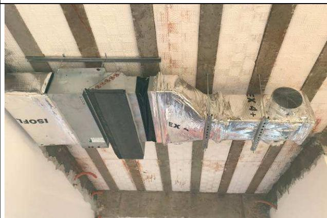
Figura 92C: Evaporadora de 2,00 HP e dutos de insuflamento - 1ª Vara.
