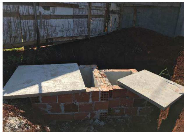
Figura 70C: Caixas de inspeção - rede de drenagem pluvial e coleta de esgoto.
