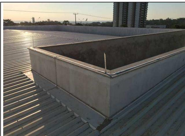
Figura 05C: Capeamento da platibanda com granito.
