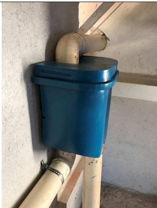
Figura 85C: Sistema de aproveitamento de águas pluviais da cobertura - filtro.
