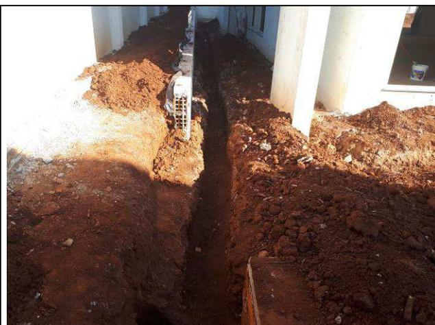
Figura 10E: Abertura de valas para execução de aterramento.
