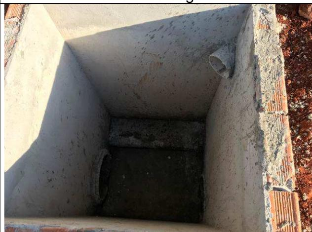
Figura 74C: Caixa de inspeção - rede de drenagem pluvial.
