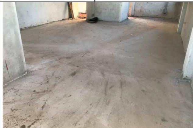
Figura 40C: Contrapiso concretado - Arquivo.
