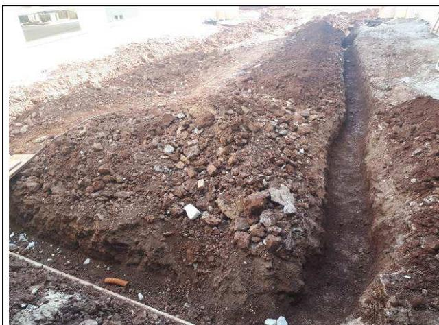
Figura 09E: Abertura de valas para execução de aterramento.
