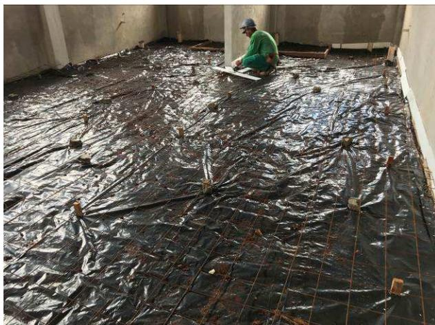
Figura 11C: Lona plástica para impermeabilização - Arquivo.
