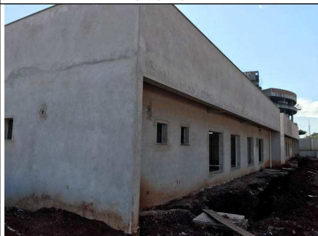
Figura 28C: Revestimento argamassado externo.
