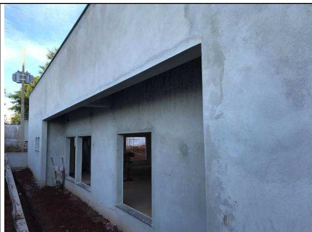
Figura 36C: Revestimento argamassado externo.
