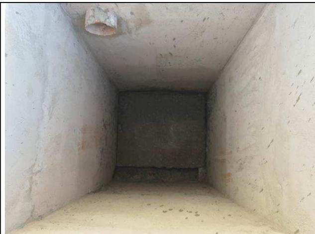
Figura 76C: Caixa de inspeção - rede de coleta de esgoto.
