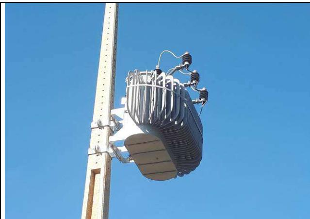
Figura 01E: Transformador e poste.
