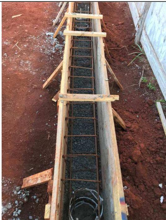
Figura 127C: Estacas e viga baldrame do gradil de fechamento.
