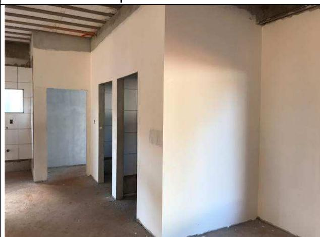
Figura 134C: Emassamento com massa PVA das paredes de alvenaria.
