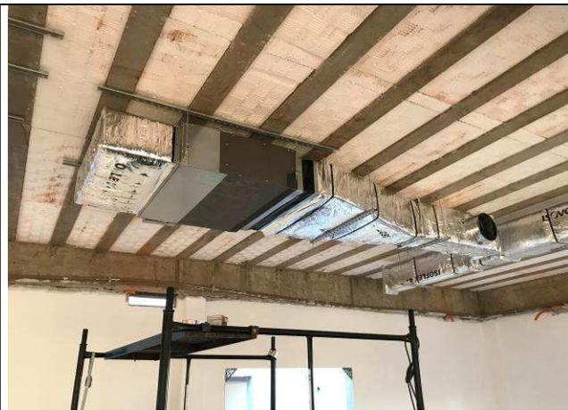
Figura 88C: Evaporadora de 2,50 HP e dutos de insuflamento - 1ª Vara.
