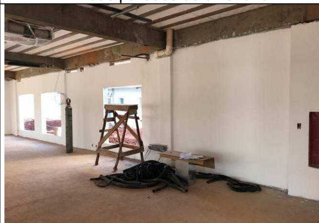
Figura 132C: Emassamento com massa PVA das paredes de alvenaria.
