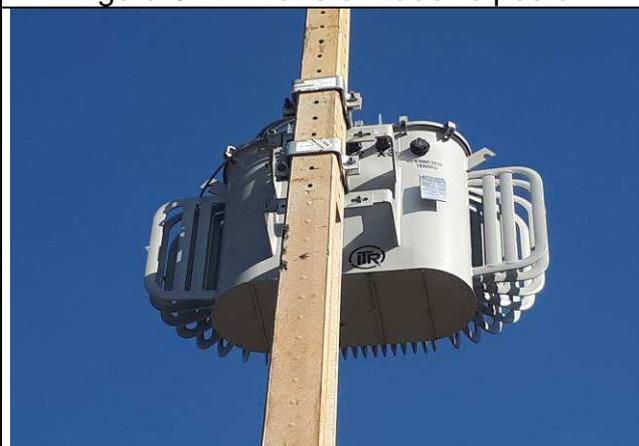
Figura 03E: Transformador e poste.
