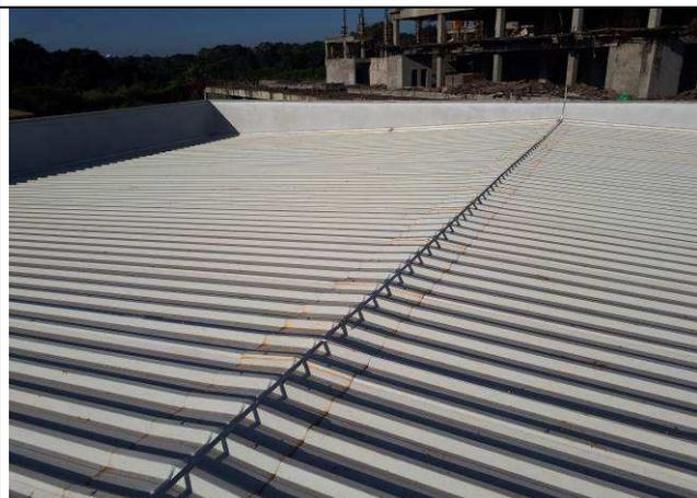
Figura 19E: Barras e hastes para captação SPDA.
