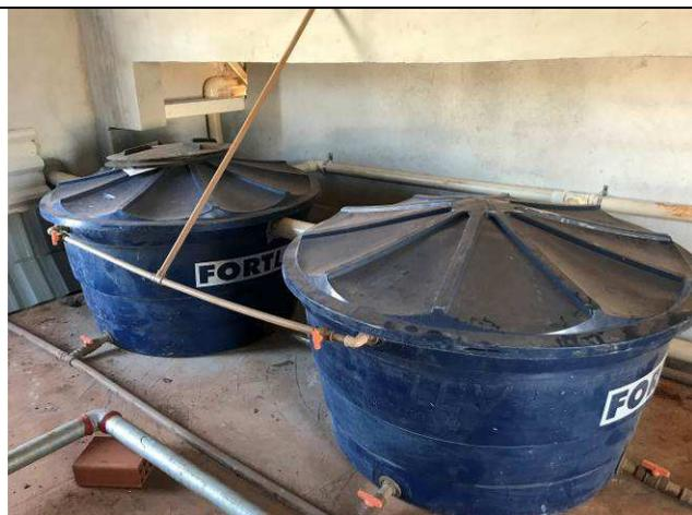
Figura 83C: Sistema de aproveitamento de águas pluviais da cobertura.
