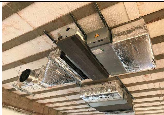
Figura 89C: Evaporadora de 1,00 HP e dutos de insuflamento - 1ª Vara.
