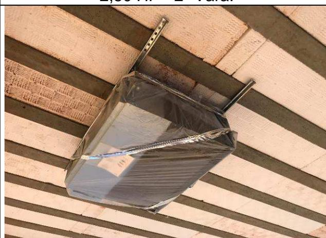
Figura 98C: Evaporadora de 2,50 HP - 2ª Vara.
