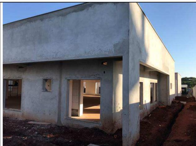
Figura 32C: Revestimento argamassado externo.
