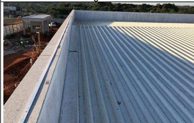
Figura 07C: Capeamento da platibanda com granito.
