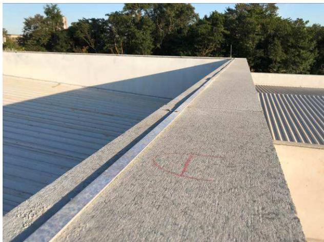
Figura 09C: Capeamento da platibanda com granito.
