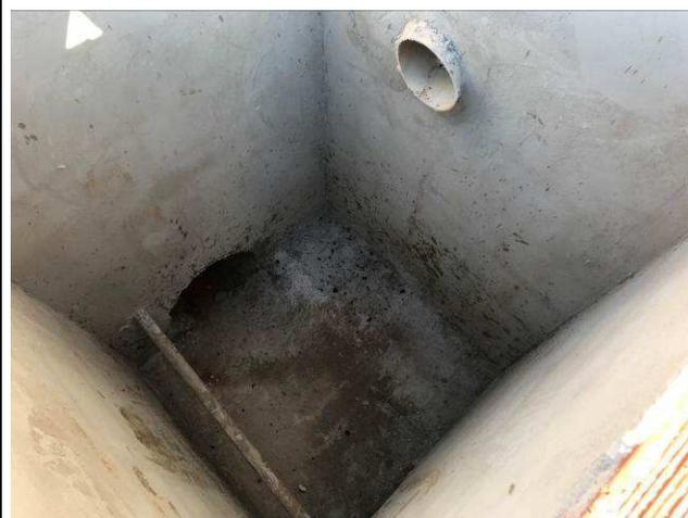
Figura 78C: Caixa de inspeção - rede de drenagem pluvial.
