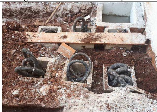
Figura 06E: Eletrodutos para alimentação dos quadros do Arquivo.
