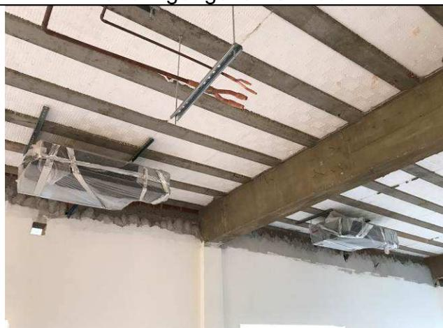
Figura 109C: Evaporadoras de 1,00 HP e 2,00 HP - 3ª Vara.
