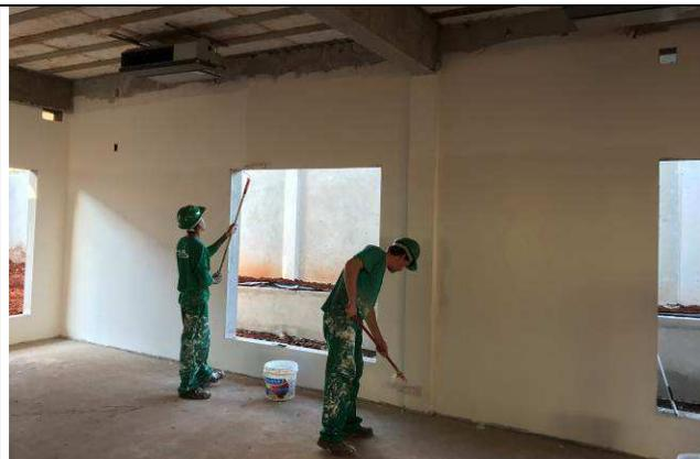
Figura 129C: Emassamento com massa PVA das paredes de alvenaria.
