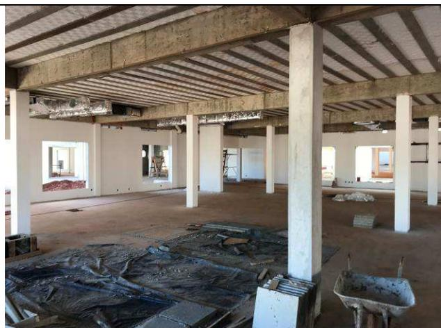
Figura 141C: Emassamento com massa PVA das paredes de alvenaria.
