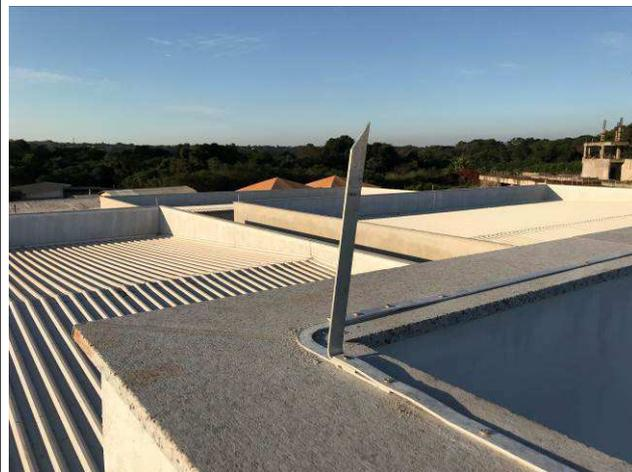
Figura 10C: Capeamento da platibanda com granito.
