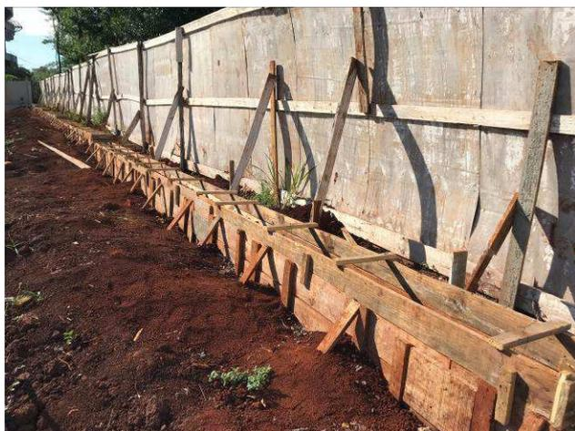
Figura 125C: Formas da viga baldrame do gradil de fechamento.
