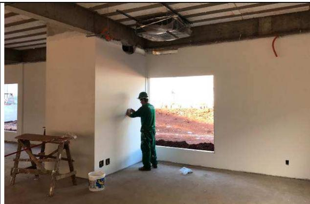
Figura 130C: Emassamento com massa PVA das paredes de alvenaria.
