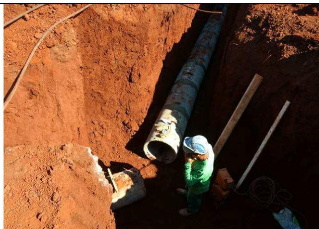
Figura 69C: Tubos de concreto - rede de drenagem pluvial.
