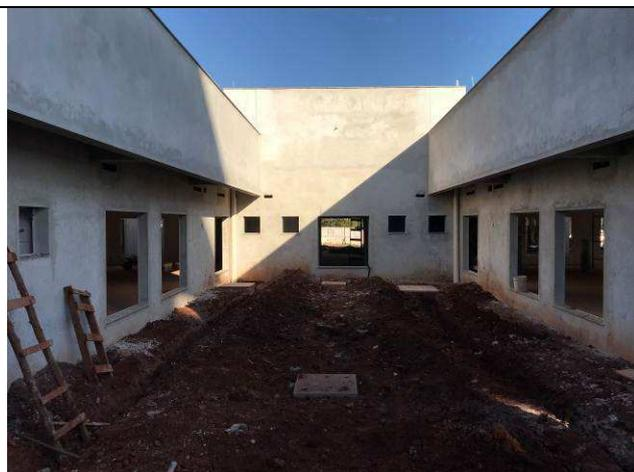
Figura 35C: Revestimento argamassado externo.
