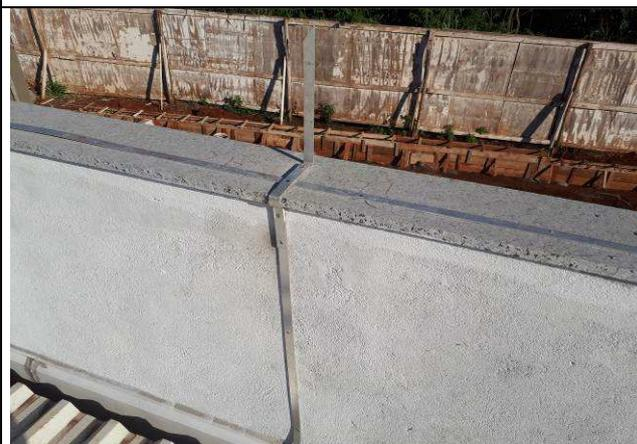
Figura 15E: Barras e hastes para captação SPDA.
