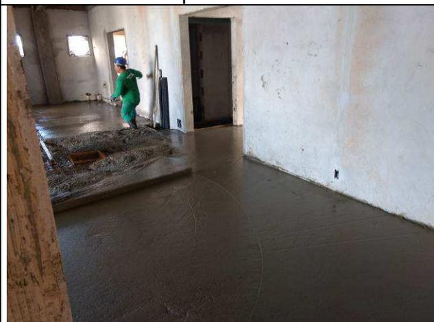
Figura 46C: Concretagem do contrapiso - Hall de entrada Fórum.
