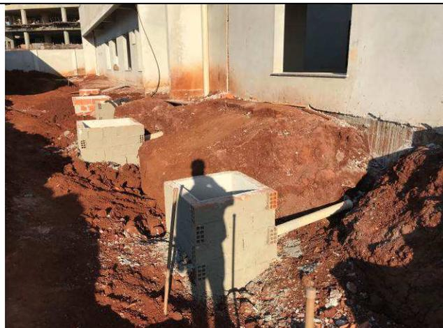
Figura 75C: Caixas de inspeção - rede de drenagem pluvial e coleta de esgoto.
