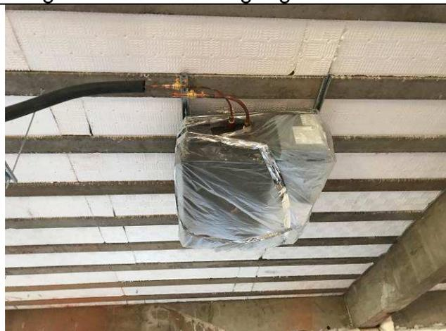
Figura 107C: Evaporadora de 2,50 HP e rede frigorígena - 3ª Vara.
