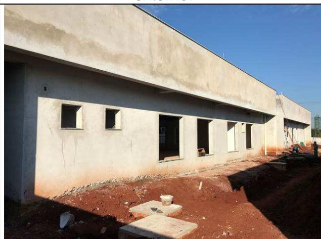
Figura 29C: Revestimento argamassado externo.
