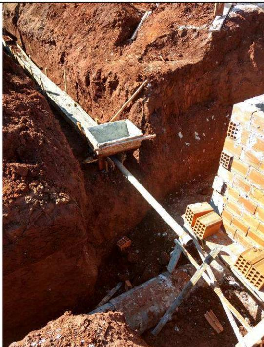
Figura 121C: Tubos externos envelopados da rede prevenção de incêndio.
