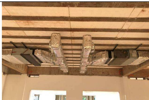
Figura 91C: Evaporadoras de 2,50 HP e dutos de insuflamento - 1ª Vara.
