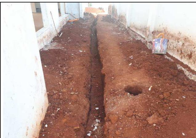
Figura 11E: Abertura de valas para execução de aterramento.
