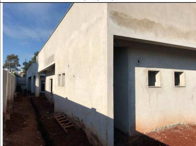
Figura 30C: Revestimento argamassado externo.
