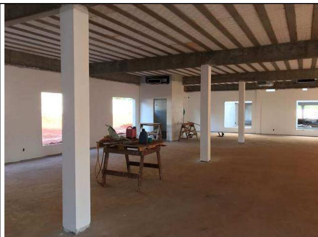
Figura 136C: Emassamento com massa PVA das paredes de alvenaria.
