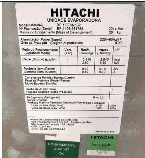
Figura 115C: 6 evaporadoras de 1,0 HP - modelo RPI1,0FSN3B2, da marca Hitachi.
