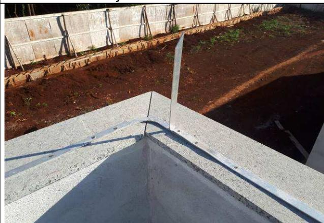
Figura 14E: Barras e hastes para captação SPDA.
