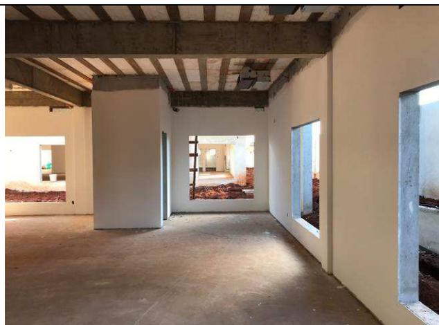
Figura 135C: Emassamento com massa PVA das paredes de alvenaria.
