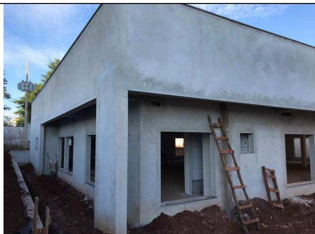
Figura 31C: Revestimento argamassado externo.
