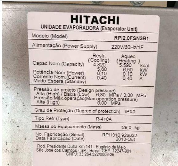
Figura 117C: 7 evaporadoras de 2,0 HP - modelo RPI2,0FSN3B1, da marca Hitachi.
