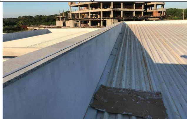
Figura 08C: Capeamento da platibanda com granito.
