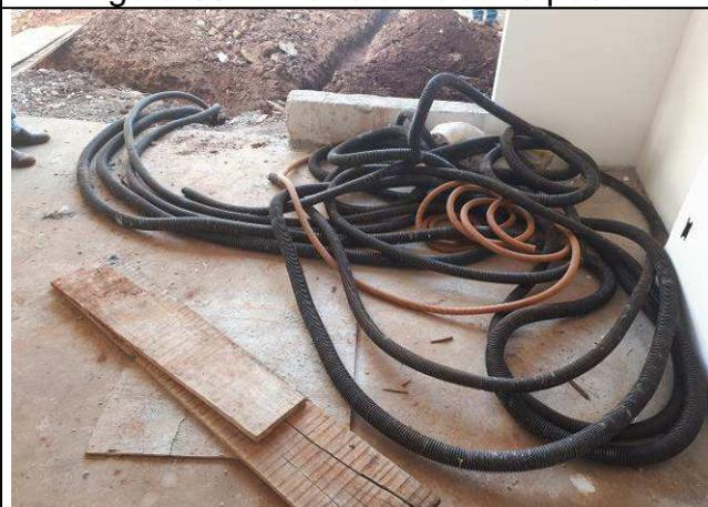
Figura 05E: Eletrodutos para circuitos externos.
