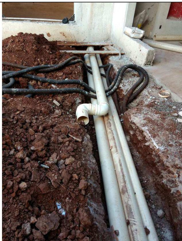
Figura 67C: Tubos de PVC - rede de drenagem pluvial.
