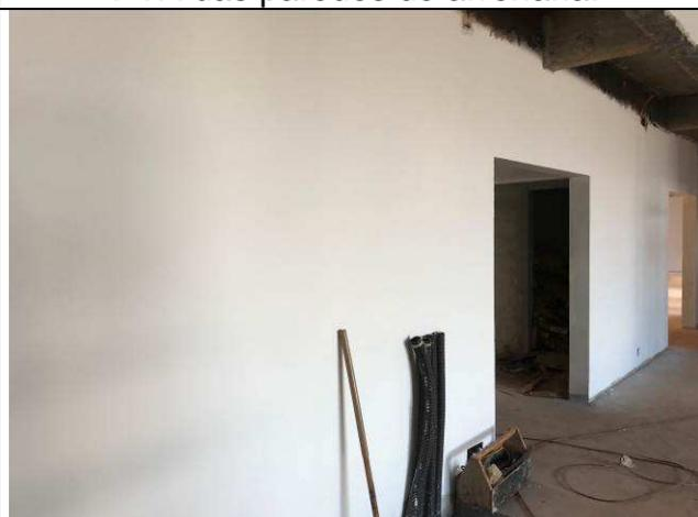
Figura 133C: Emassamento com massa PVA das paredes de alvenaria.
