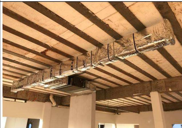
Figura 90C: Evaporadora de 2,50 HP e dutos de insuflamento - 1ª Vara.
