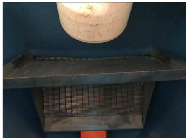
Figura 86C: Sistema de aproveitamento de águas pluviais da cobertura - filtro - peneira interna de aço inox.
