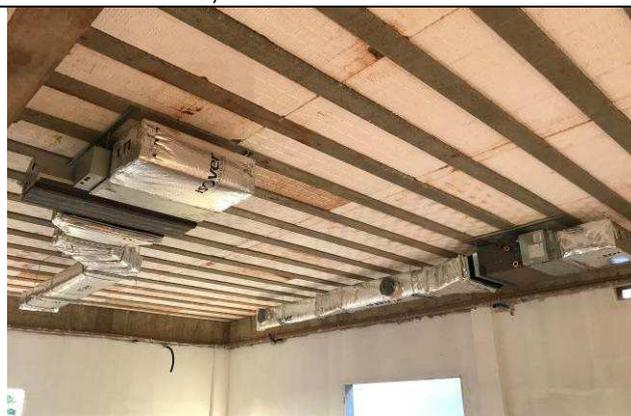
Figura 113C: Evaporadoras de 1,00 HP e 1,50 HP e dutos de insuflamento - Apoio.
