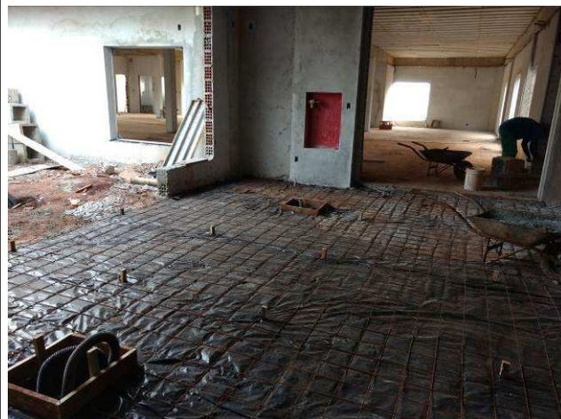
Figura 12C: Lona plástica para impermeabilização - Hall central do Fórum.
