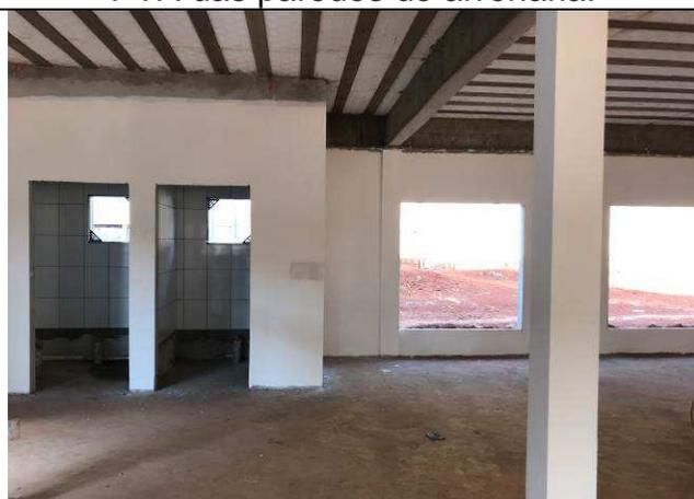
Figura 137C: Emassamento com massa PVA das paredes de alvenaria.
