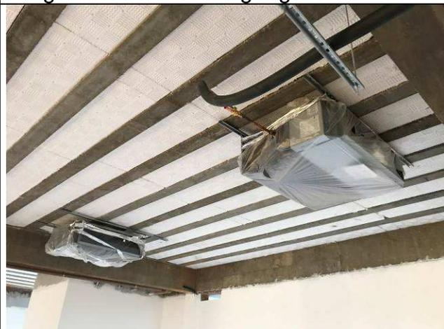
Figura 108C: Evaporadoras de 2,50 HP - 3ª Vara.
