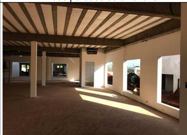
Figura 146C: Emassamento com massa PVA das paredes de alvenaria.
