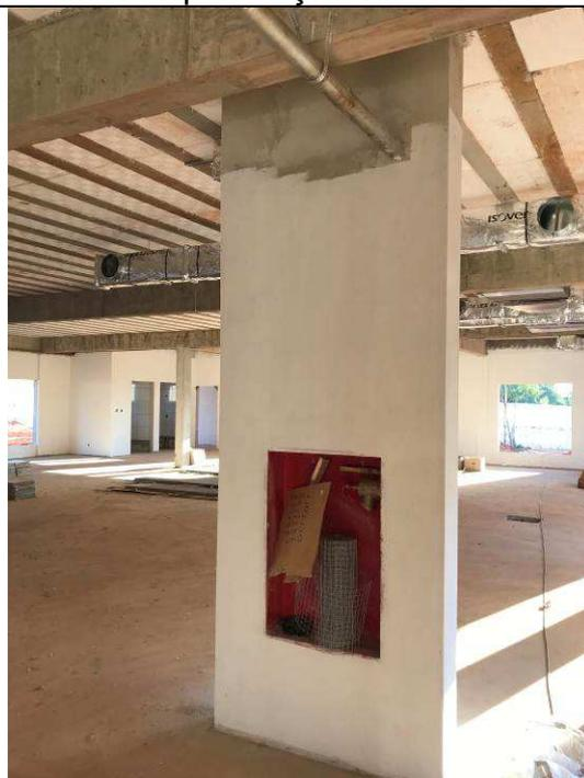
Figura 124C: Abrigo para hidrante - 1ª Vara.
