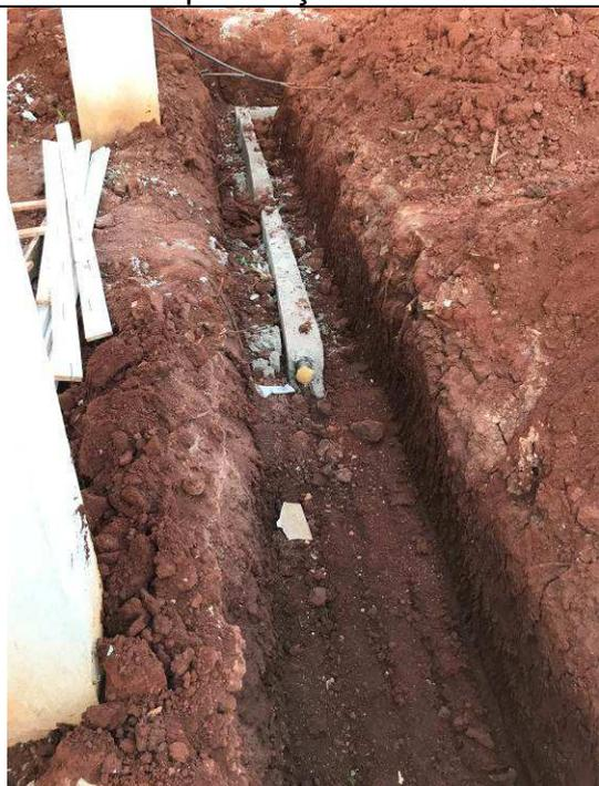
Figura 123C: Tubos externos envelopados da rede prevenção de incêndio.
