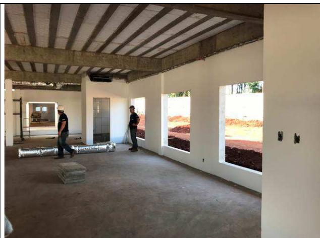
Figura 142C: Emassamento com massa PVA das paredes de alvenaria.
