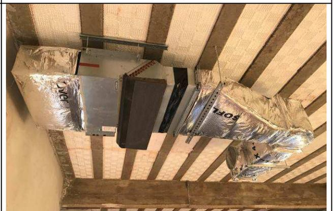
Figura 114C: Evaporadora de 2,00 HP - Módulo de Apoio.
