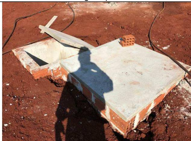
Figura 71C: Caixas de inspeção - rede de drenagem pluvial e coleta de esgoto.
