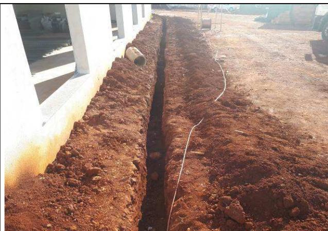
Figura 12E: Abertura de valas para execução de aterramento.
