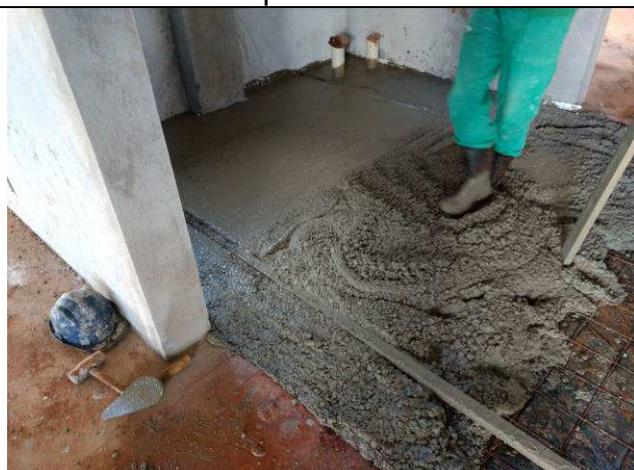
Figura 45C: Concretagem do contrapiso - Hall de entrada Fórum.
