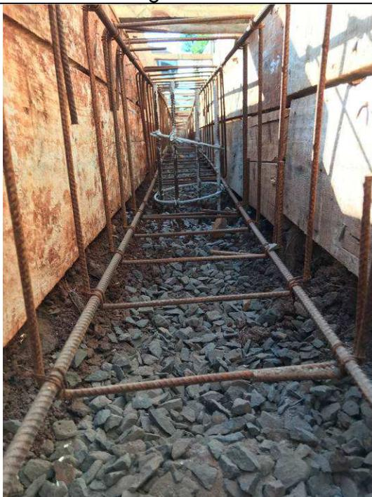
Figura 128C: Formas e armaduras da viga baldrame do gradil de fechamento.
