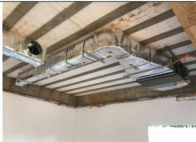
Figura 87C: Evaporadora de 2,50 HP e dutos de insuflamento - 1ª Vara.
