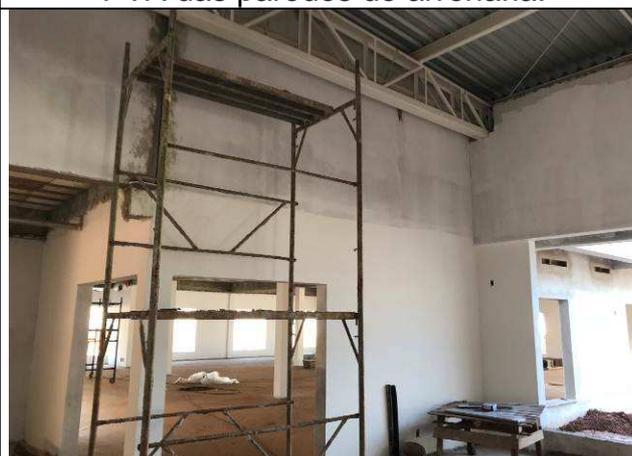
Figura 138C: Emassamento com massa PVA das paredes de alvenaria.
