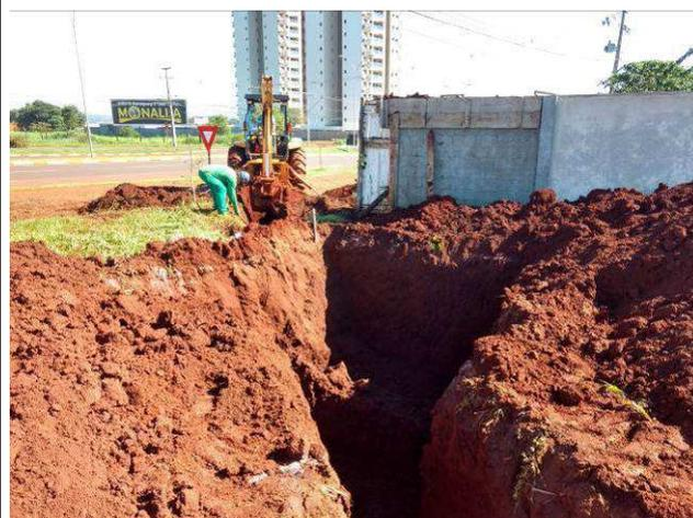
Figura 02C: Abertura de valas para passagem das tubulações - interligação da rede de águas pluviais à galeria pública.
