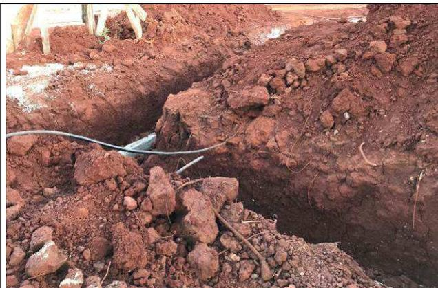
Figura 04C: Abertura de valas para passagem das tubulações.
