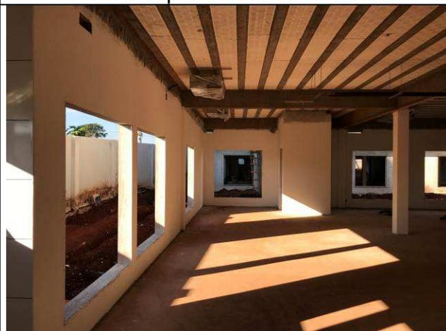
Figura 144C: Emassamento com massa PVA das paredes de alvenaria.
