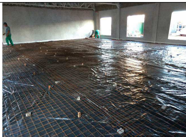
Figura 77C: Aplicação da lona e da tela metálica - contrapiso Arquivo.
