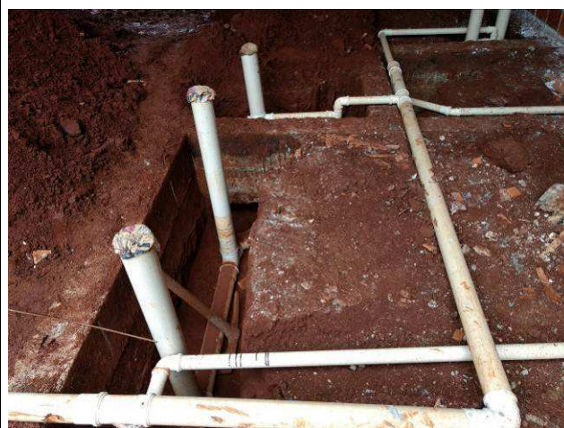
Figura 06C: Abertura de valas internas.
