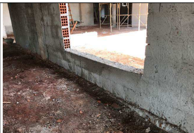
Figura 12C: Vergas e contravergas do Fórum.
