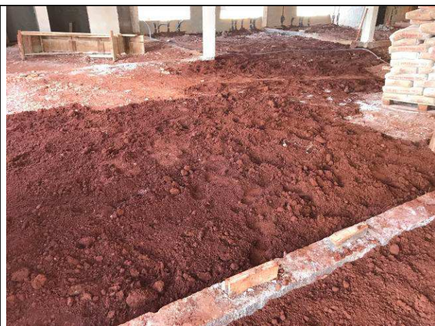
Figura 07C: Reaterro entre baldrames.
