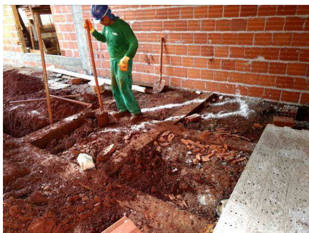
Figura 05C: Abertura de valas internas.
