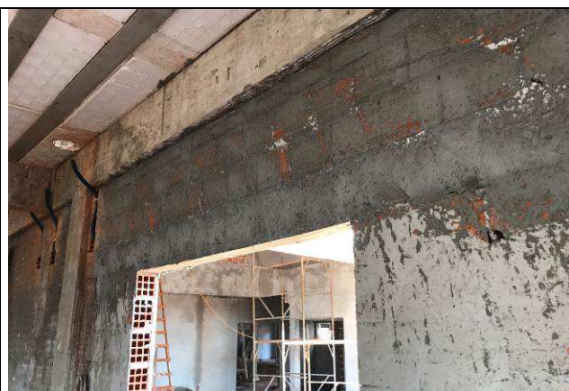
Figura 11C: Vergas e contravergas do Fórum.
