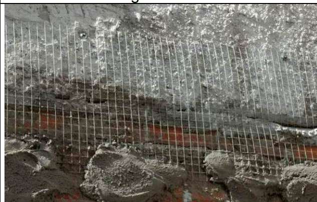
Figura 64C: Instalação da tela na junta alvenaria x viga cobertura - Fórum.
