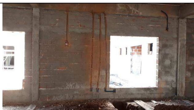
Figura 21E: Eletrodutos e abertura para caixas embutidas em alvenaria - segundo quadrante à esquerda.
