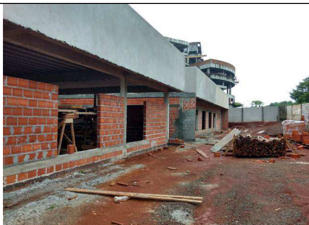
Figura 15C: Vergas e contravergas do Fórum.
