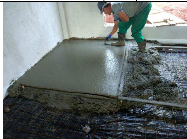
Figura 80C: Concretagem e nivelamento - contrapiso Arquivo.
