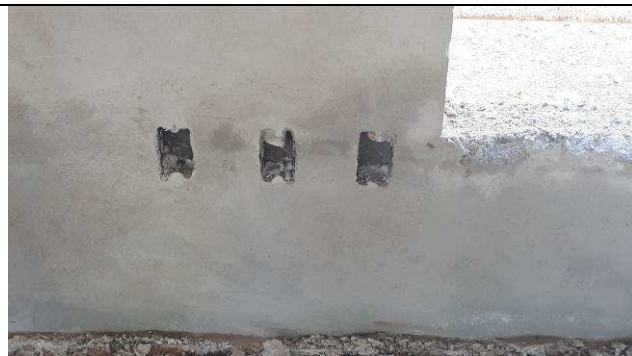
Figura 03E: Eletrodutos e caixas embutidas em alvenaria - primeiro quadrante à direita.
