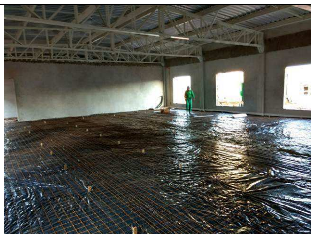
Figura 53C: Lona plástica para impermeabilização do contrapiso - Arquivo.
