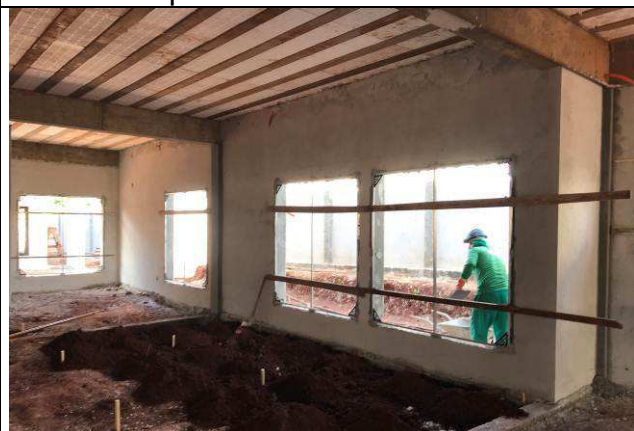
Figura 60C: Revestimento argamassado das paredes internas - Fórum.
