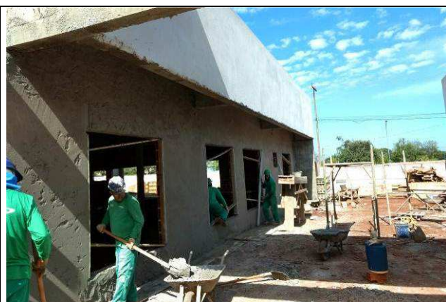
Figura 65C: Revestimento argamassado da face externa - Fórum.
