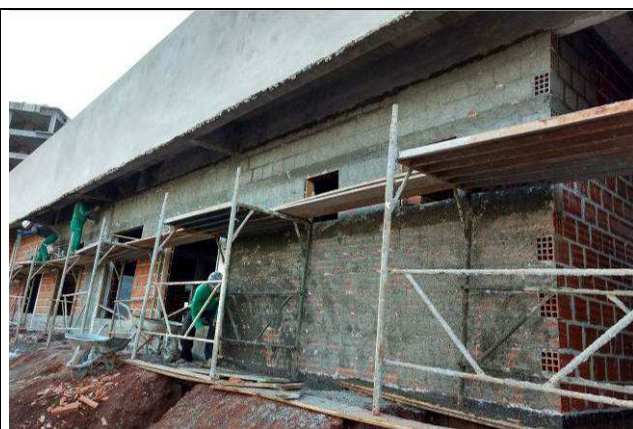
Figura 66C: Revestimento argamassado da face externa - Fórum.
