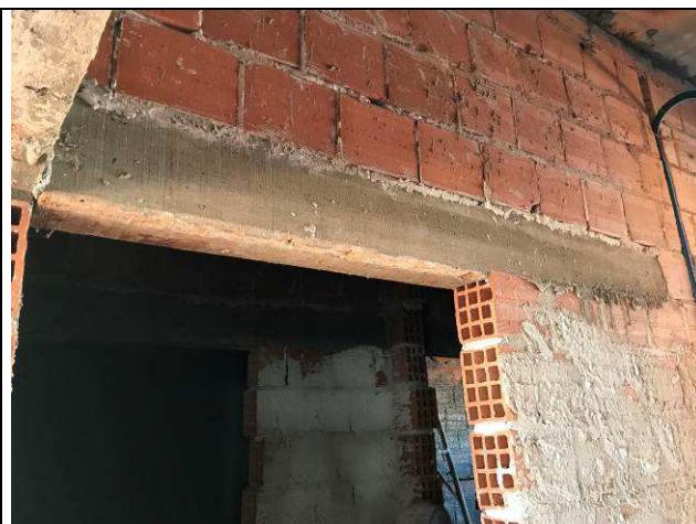
Figura 14C: Vergas e contravergas do Fórum.
