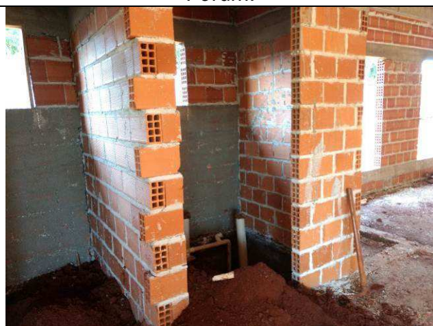
Figura 29C: Alvenarias internas do Fórum.
