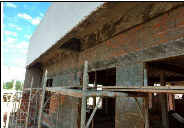
Figura 19C: Alvenarias de vedação do Fórum - encunhamento.
