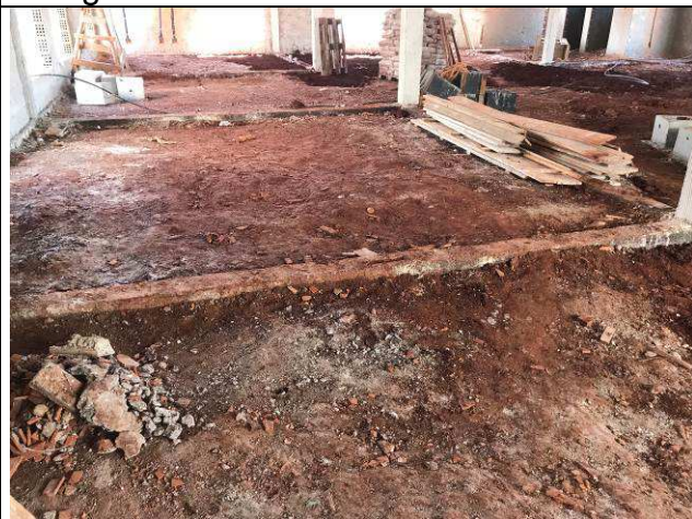
Figura 10C: Reaterro entre baldrames.
