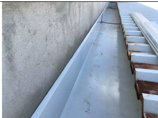
Figura 41C: Calha de cobertura do barrilete - Fórum.
