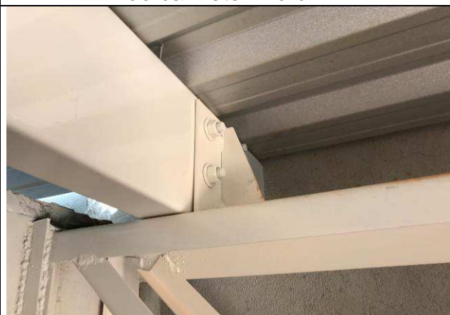
Figura 35C: Estrutura metálica de cobertura do barrilete - Fórum.
