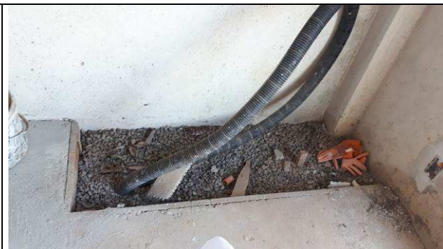
Figura 30E: Eletrodutos 2" para infraestrutura lógica rack Arquivo.
