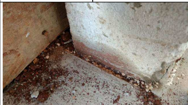
Figura 88C: Junta de isopor entre o contra piso e as paredes de alvenaria - Arquivo.
