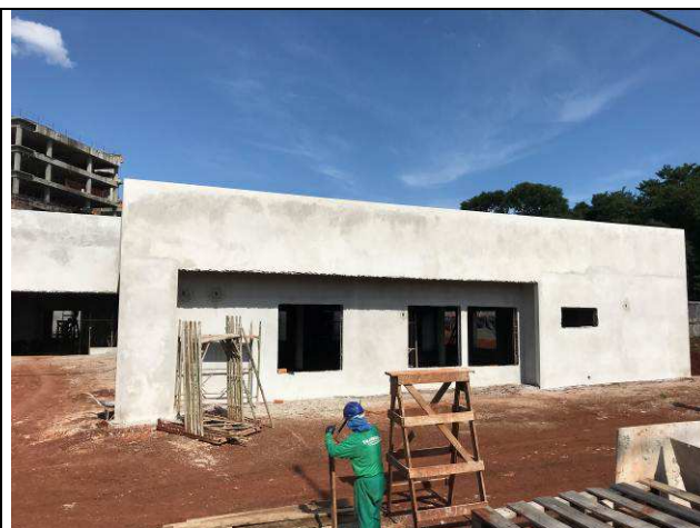
Figura 26C: Alvenarias de vedação do Fórum.
