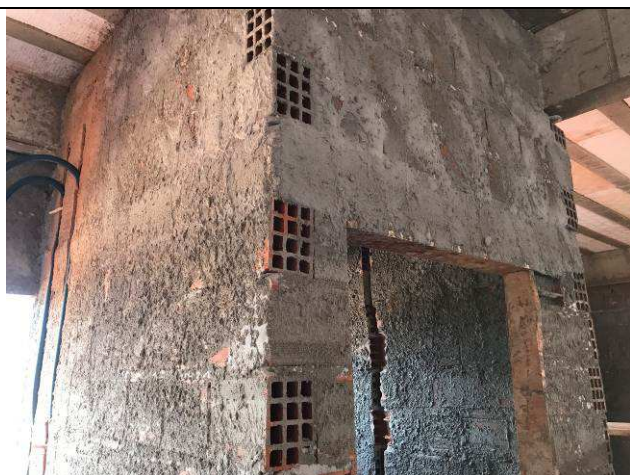
Figura 13C: Vergas e contravergas do Fórum.
