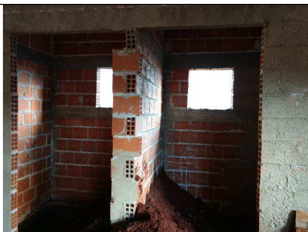
Figura 17C: Vergas e contravergas do Fórum.
