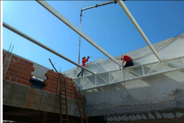
Figura 31C: Montagem da estrutura metálica de cobertura do barrilete - Fórum.
