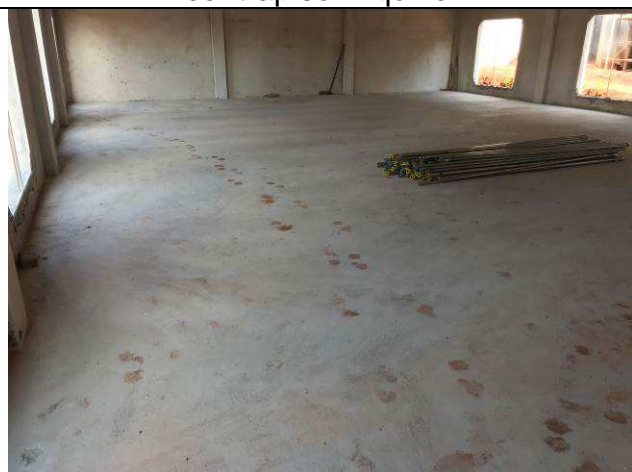
Figura 85C: Contrapiso concretado - Arquivo.
