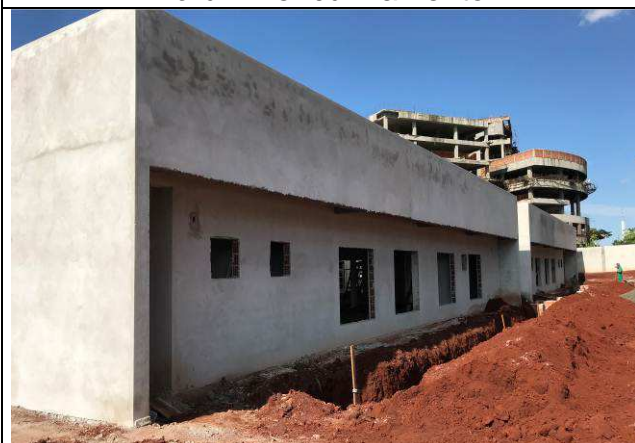
Figura 21C: Alvenarias de vedação do Fórum.
