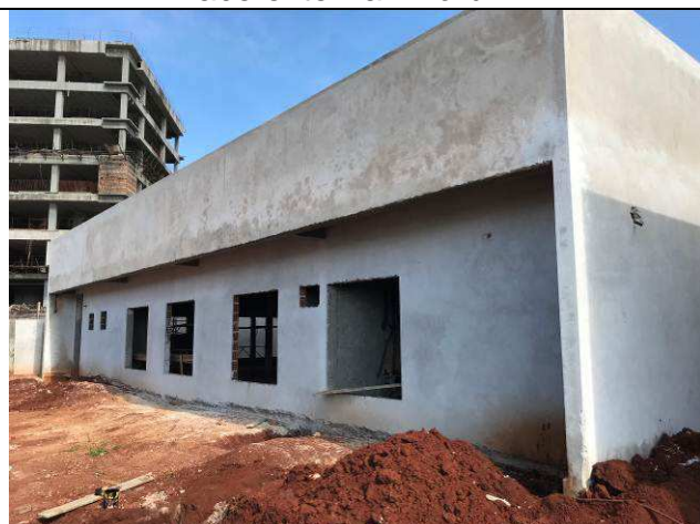
Figura 71C: Revestimento argamassado da face externa - Fórum.
