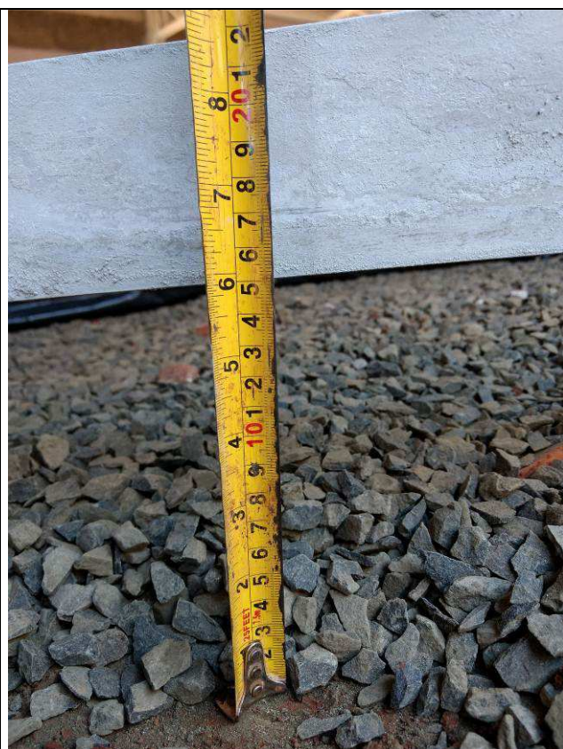
Figura 75C: Camada de brita - contrapiso Arquivo.
