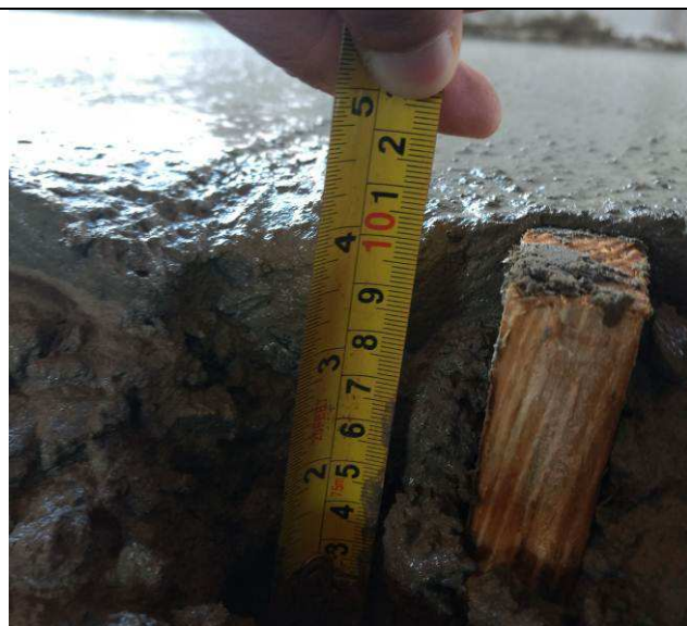
Figura 83C: Camada de concreto - contrapiso Arquivo.
