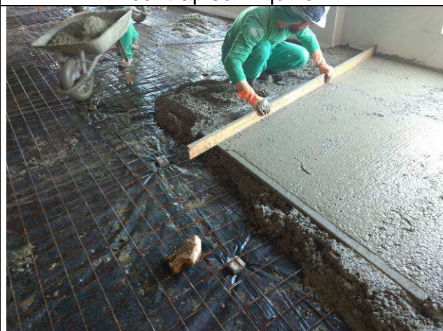
Figura 82C: Concretagem e nivelamento - contrapiso Arquivo.
