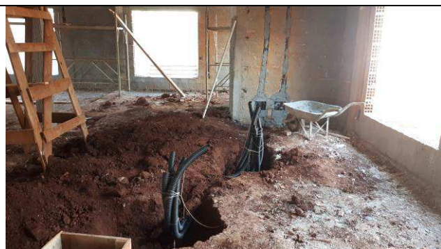
Figura 23E: Eletrodutos - pisos das salas de audiências - segundo quadrante à esquerda.
