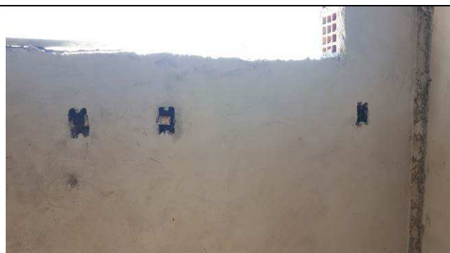
Figura 01E: Eletrodutos e caixas embutidas em alvenaria - primeiro quadrante à direita.
