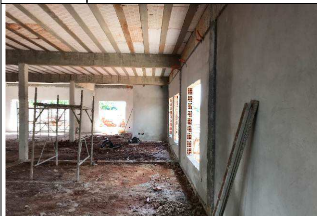
Figura 57C: Revestimento argamassado das paredes internas - Fórum.
