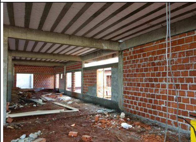
Figura 16C: Vergas e contravergas do Fórum.
