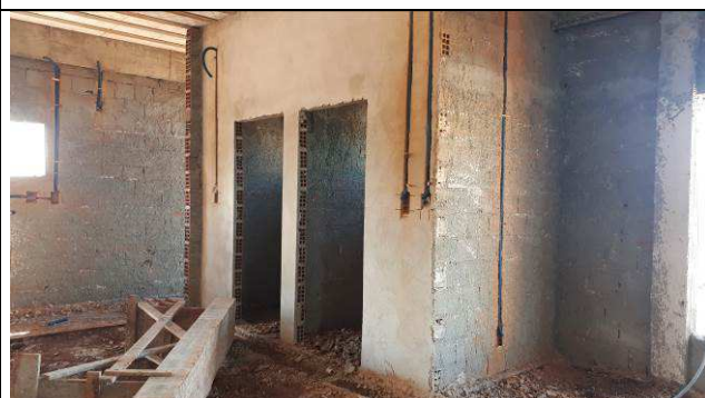
Figura 07E: Eletrodutos e abertura para caixas embutidas em alvenaria - primeiro quadrante à esquerda.
