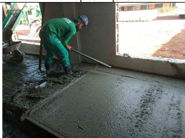
Figura 81C: Concretagem e nivelamento - contrapiso Arquivo.
