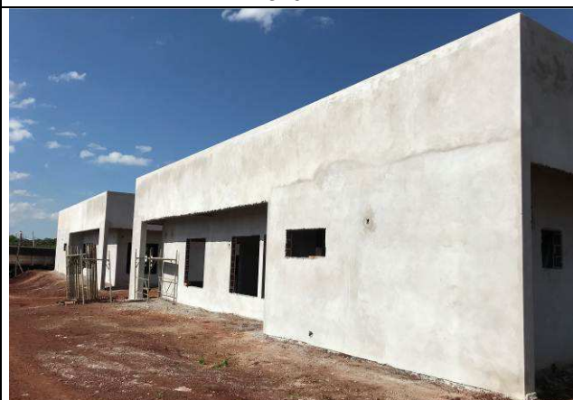
Figura 22C: Alvenarias de vedação do Fórum.
