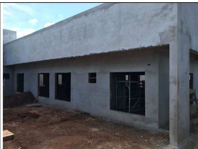
Figura 73C: Revestimento argamassado da face externa - Fórum.
