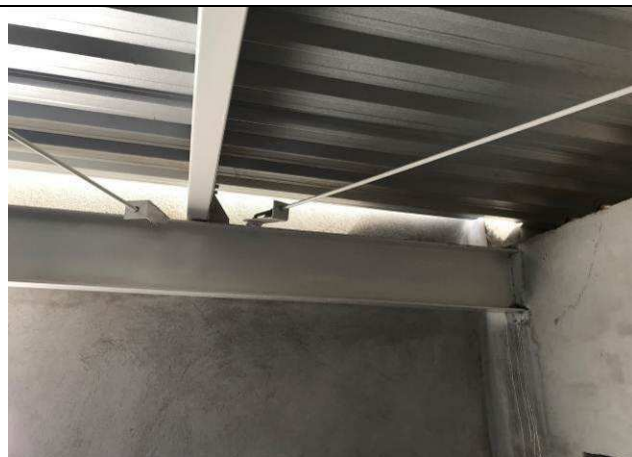
Figura 37C: Estrutura metálica de cobertura do barrilete - Fórum.
