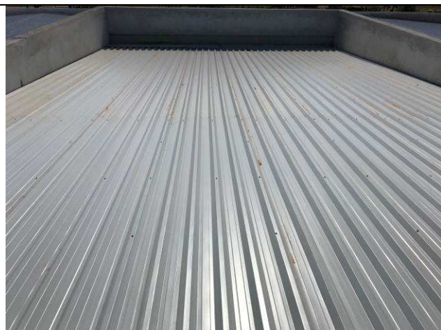
Figura 39C: Telhas metálicas de cobertura do barrilete - Fórum.
