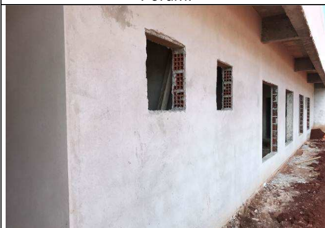
Figura 23C: Alvenarias de vedação do Fórum.
