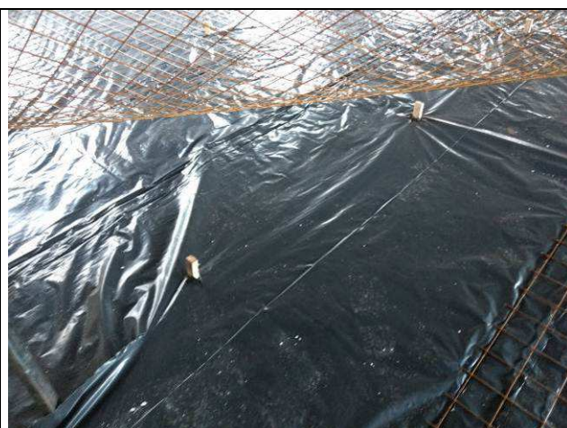
Figura 54C: Lona plástica para impermeabilização do contrapiso - Arquivo.
