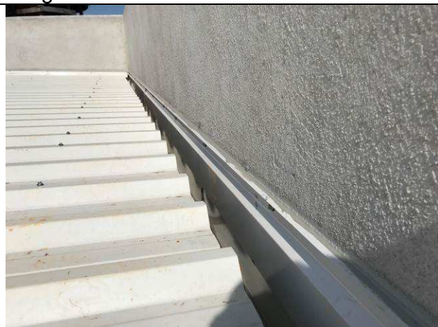
Figura 45C: Calhas e rufos de cobertura - Fórum.
