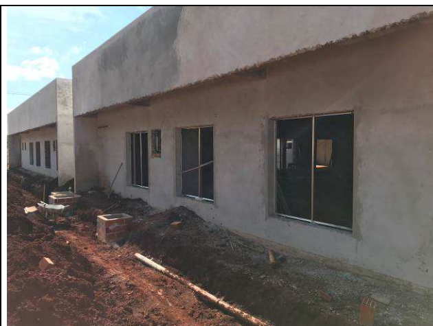
Figura 74C: Revestimento argamassado da face externa - Fórum.
