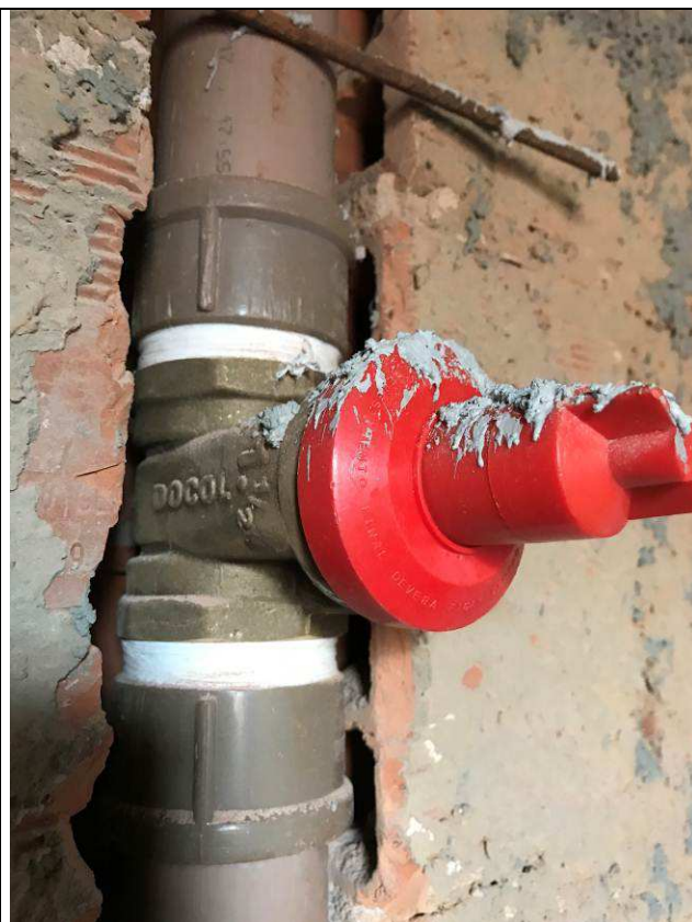
Figura 104C: Registro gaveta de 1 1/2" - válvula de descarga - Fórum.
