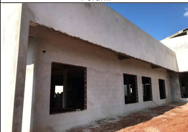
Figura 24C: Alvenarias de vedação do Fórum.
