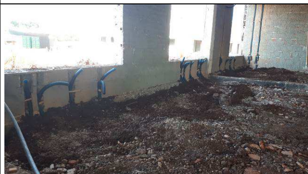
Figura 09E: Eletrodutos e abertura para caixas embutidas em alvenaria - primeiro quadrante à esquerda.
