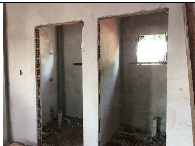
Figura 61C: Revestimento argamassado das paredes internas - Fórum.
