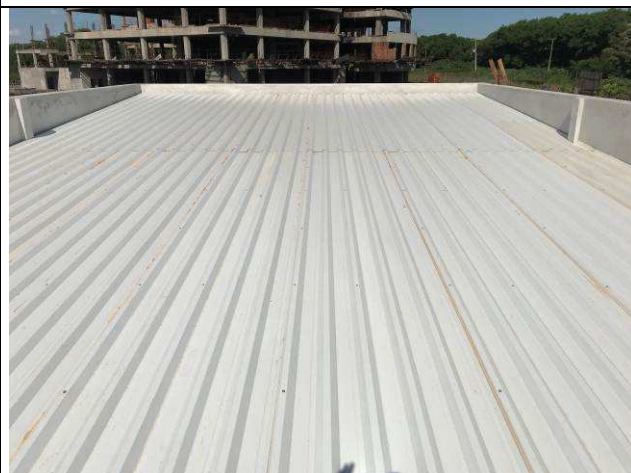
Figura 40C: Telhas metálicas de cobertura do barrilete - Fórum.
