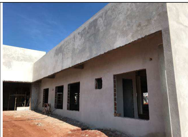
Figura 68C: Revestimento argamassado da face externa - Fórum.
