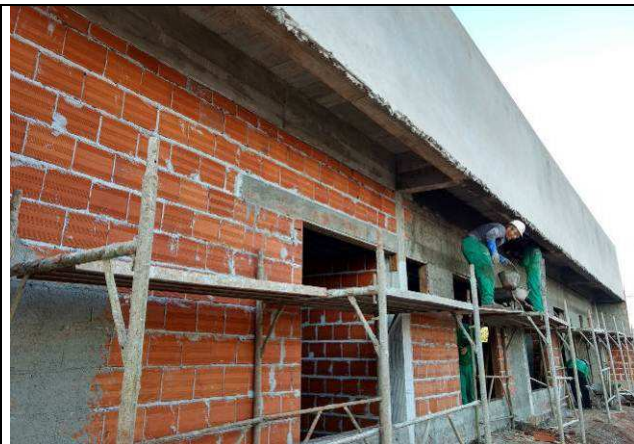
Figura 20C: Alvenarias de vedação do Fórum.
