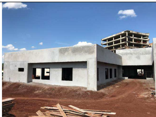
Figura 25C: Alvenarias de vedação do Fórum.
