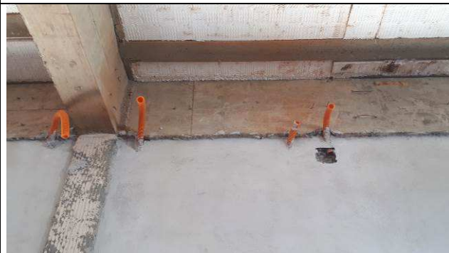
Figura 04E: Eletrodutos e caixas embutidas em alvenaria - primeiro quadrante à direita.
