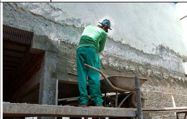
Figura 63C: Instalação da tela na junta alvenaria x viga cobertura - Fórum.
