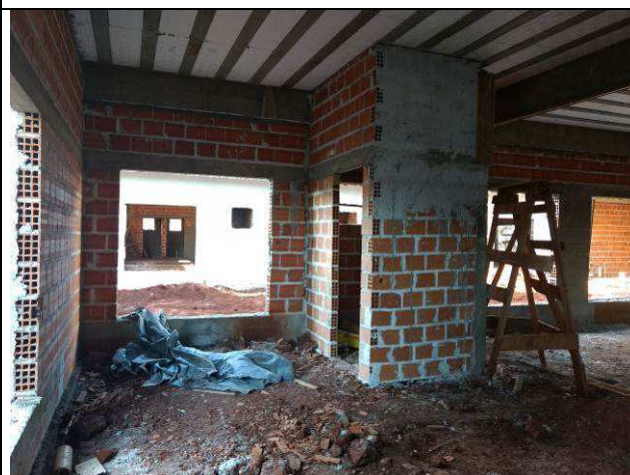
Figura 30C: Alvenarias internas do Fórum.
