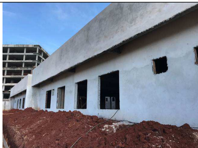
Figura 27C: Alvenarias de vedação do Fórum.
