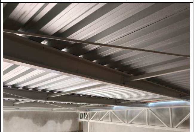
Figura 36C: Estrutura metálica de cobertura do barrilete - Fórum.
