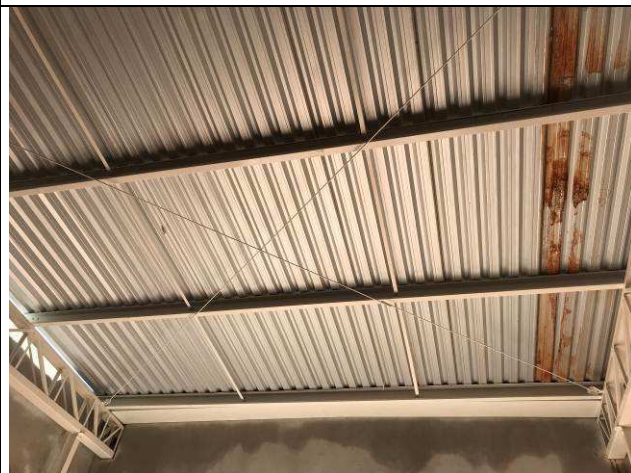
Figura 33C: Estrutura metálica de cobertura do barrilete - Fórum.
