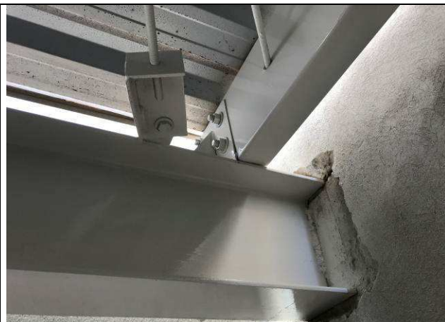
Figura 38C: Estrutura metálica de cobertura do barrilete - Fórum.
