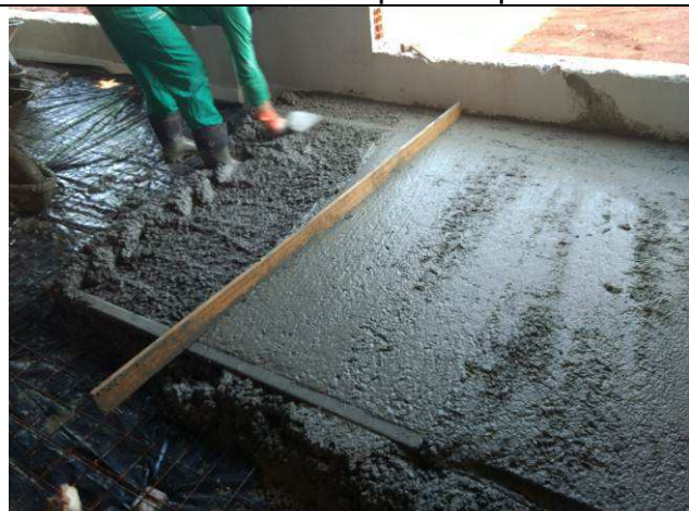
Figura 79C: Concretagem e nivelamento - contrapiso Arquivo.
