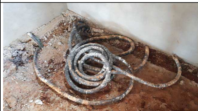
Figura 28E: Eletrodutos 2" para infraestrutura lógica rack Arquivo.
