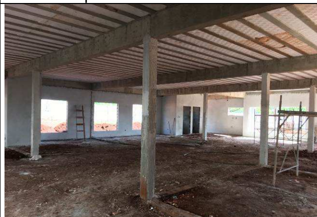
Figura 58C: Revestimento argamassado das paredes internas - Fórum.
