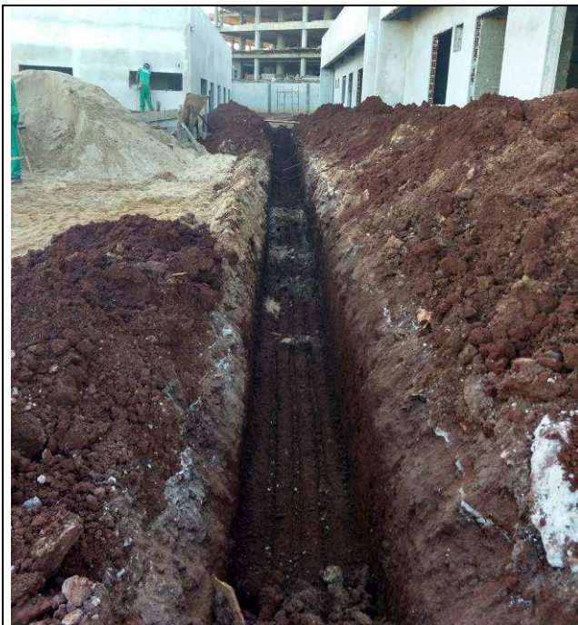
Figura 01C: Abertura de valas para passagem das tubulações.
