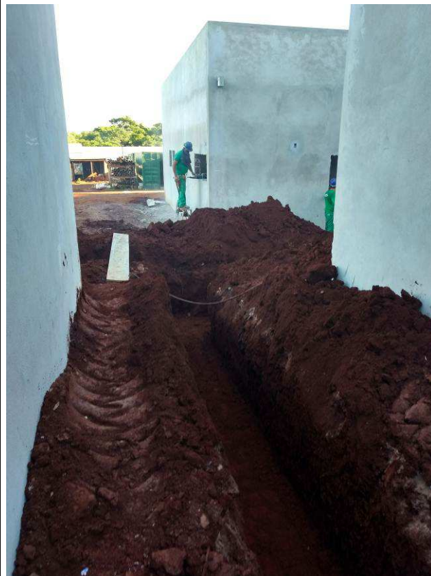
Figura 04C: Abertura de valas para passagem das tubulações.
