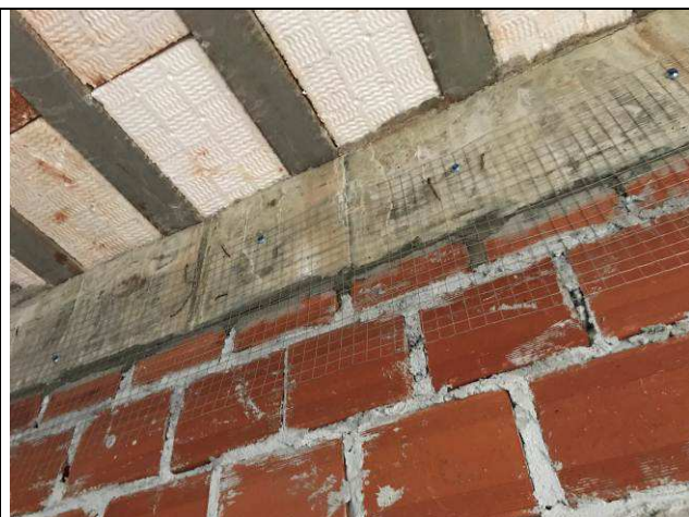
Figura 62C: Instalação da tela na junta alvenaria x viga cobertura - Fórum.
