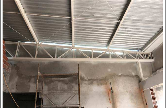
Figura 32C: Estrutura metálica de cobertura do barrilete - Fórum.
