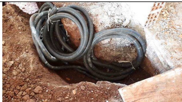
Figura 29E: Eletrodutos 2" para infraestrutura lógica rack Arquivo.
