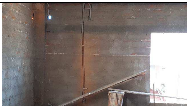
Figura 17E: Eletrodutos e abertura para caixas embutidas em alvenaria - segundo quadrante à esquerda.
