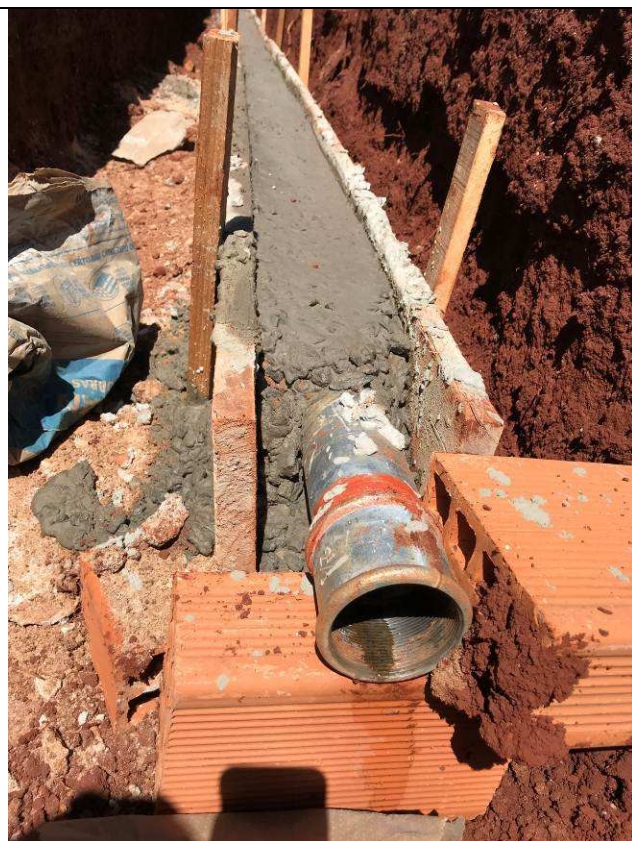
Figura 115C: Tubulação da rede de hidrantes - envelopamento com concreto.
