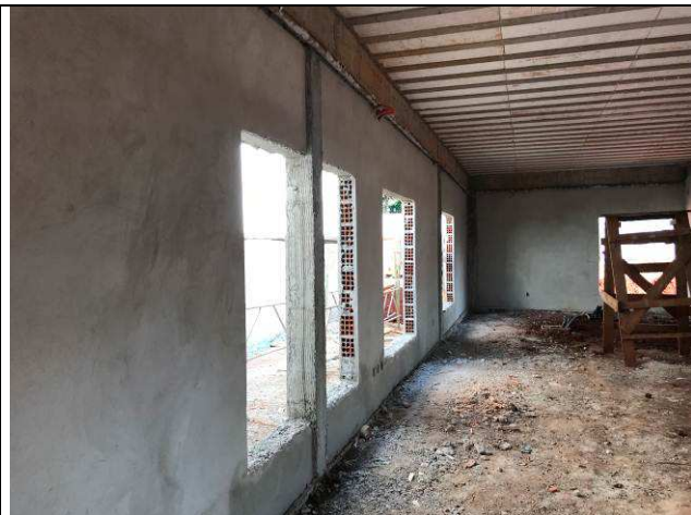
Figura 56C: Revestimento argamassado das paredes internas - Fórum.
