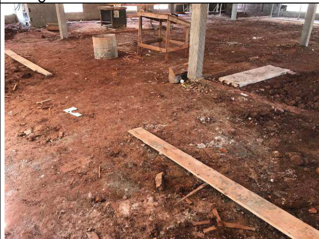
Figura 09C: Reaterro entre baldrames.
