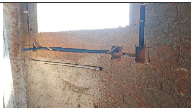
Figura 08E: Eletrodutos e abertura para caixas embutidas em alvenaria - primeiro quadrante à esquerda.
