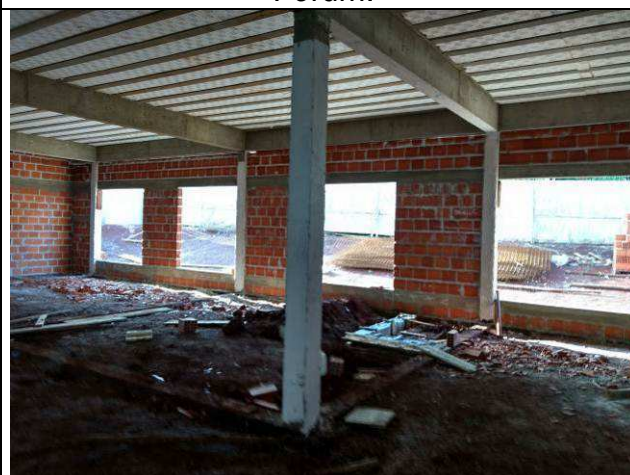
Figura 18C: Vergas e contravergas do Fórum.
