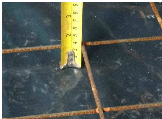
Figura 78C: Aplicação da lona e da tela metálica - contrapiso Arquivo.
