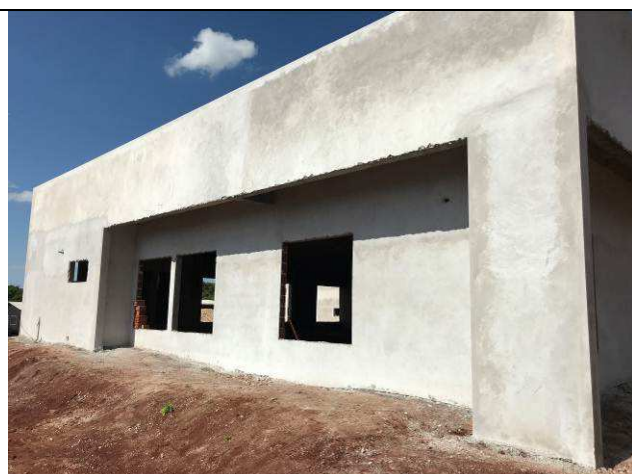
Figura 69C: Revestimento argamassado da face externa - Fórum.
