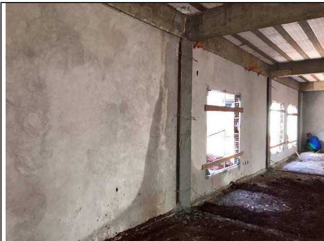
Figura 55C: Revestimento argamassado das paredes internas - Fórum.
