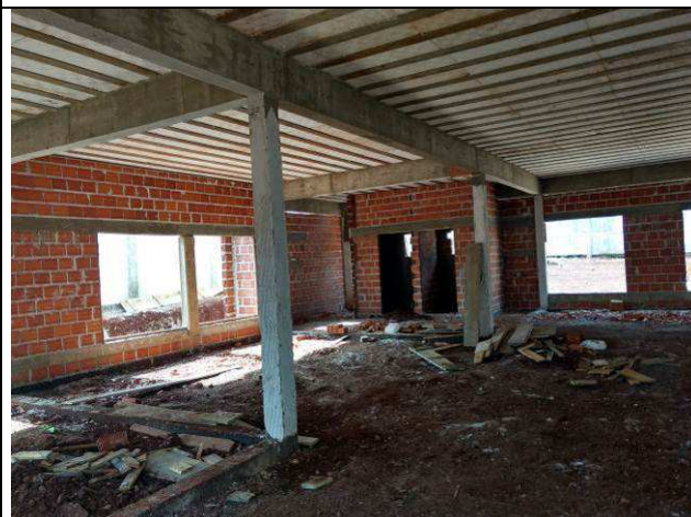
Figura 28C: Alvenarias internas do Fórum.
