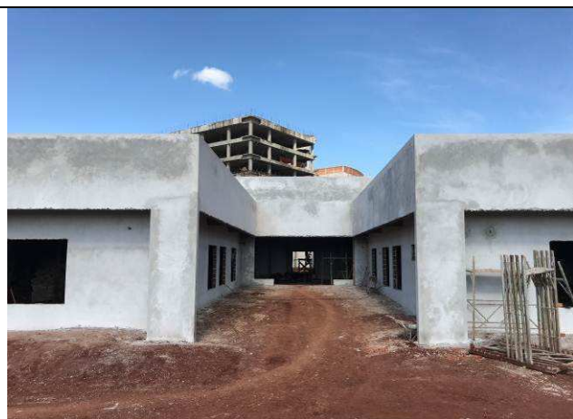
Figura 67C: Revestimento argamassado da face externa - Fórum.
