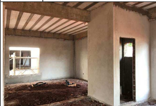
Figura 59C: Revestimento argamassado das paredes internas - Fórum.
