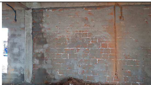
Figura 19E: Eletrodutos e abertura para caixas embutidas em alvenaria - segundo quadrante à esquerda.
