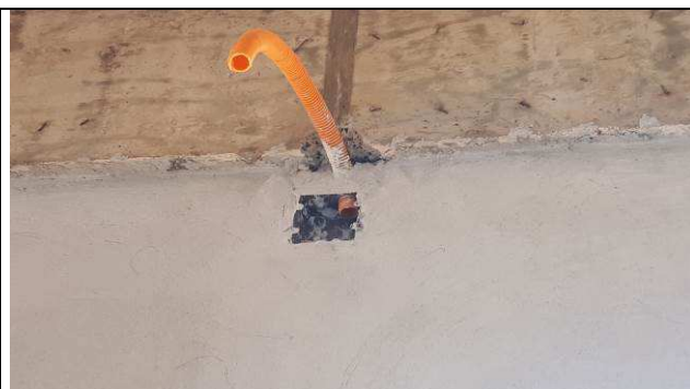
Figura 02E: Eletrodutos e caixas embutidas em alvenaria - primeiro quadrante à direita.
