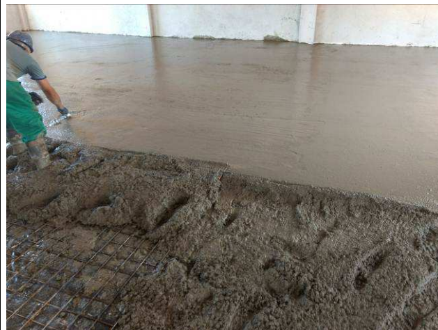
Figura 84C: Concretagem e nivelamento - contrapiso Arquivo.
