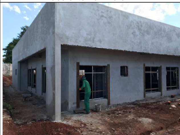
Figura 72C: Revestimento argamassado da face externa - Fórum.
