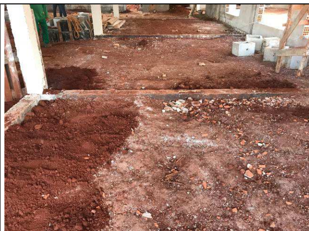
Figura 08C: Reaterro entre baldrames.
