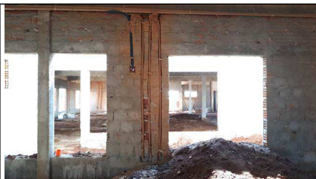
Figura 18E: Eletrodutos e abertura para caixas embutidas em alvenaria - segundo quadrante à esquerda.
