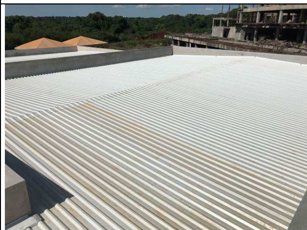
Figura 48C: Telhas de cobertura - Fórum.
