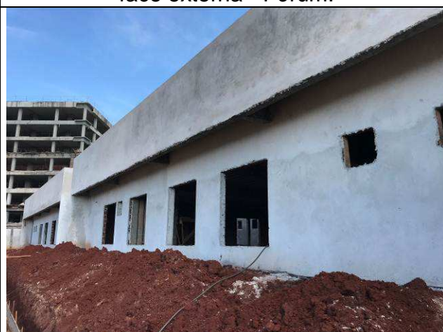
Figura 70C: Revestimento argamassado da face externa - Fórum.
