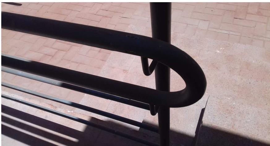
Figura 18.13: Corrimão metálico, com altura dupla (92cm e 70cm).
