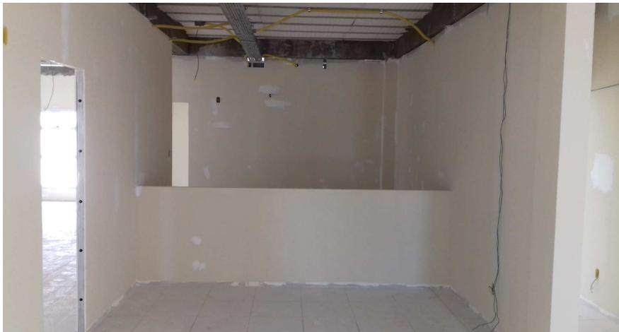
Figura 6.1: parede de gesso acartonado simples, instalada no bcão de atendimento
