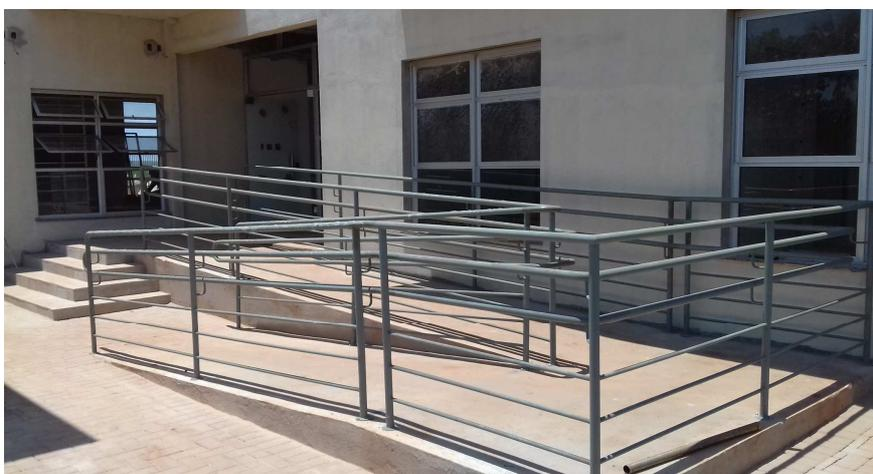
Figura 18.12: Guarda-corpo, instalado na rampa de acesso ao imóvel.
