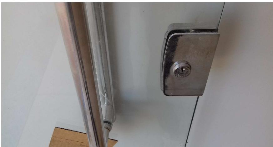
Figura 7.2: Detalhe de fechadura da porta de vidro.
