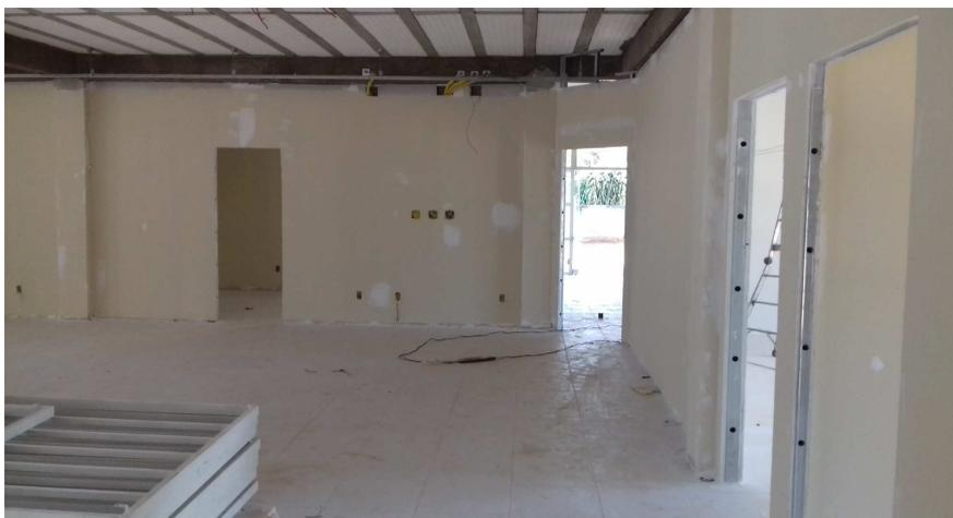
Figura 6.3: parede de gesso acartonado dupla, instalada em sala de audiência e pré-acordo.
