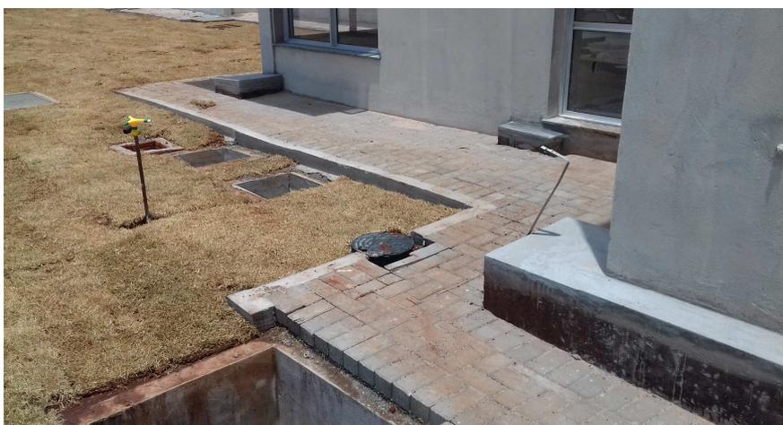
Figura 18.3: Calçada em paver, localizada no perímetro do imóvel.
