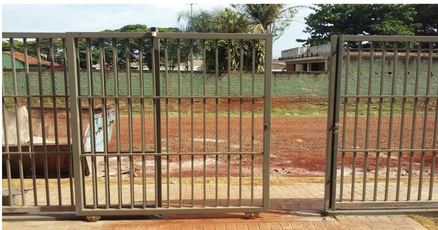
Figura 18.14: Portão de pedestres, de correr, instalado na entrada principal do imóvel.
