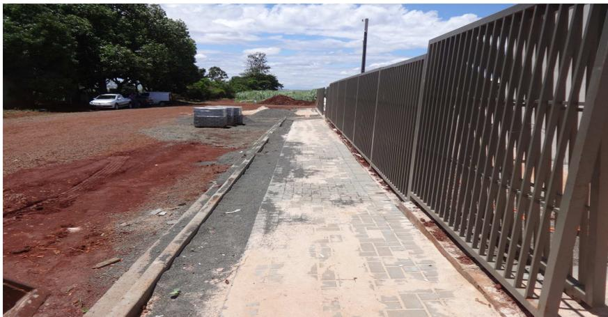
Figura 18.10: Meio-fio com sarjeta, instalado na área externa.
