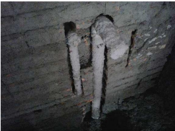
Figura 73C: Ponto de água fria e ponto de esgoto secundário instalados em banheiro da secretaria
