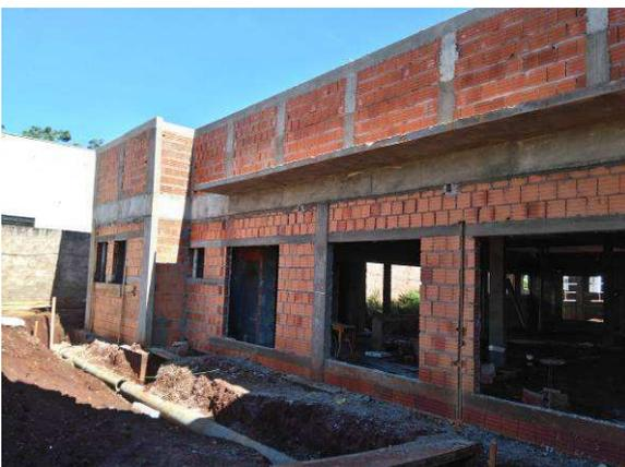
Figura 07C: Detalhe vigas cintas e pilaretes de travamento da platibanda - face leste
