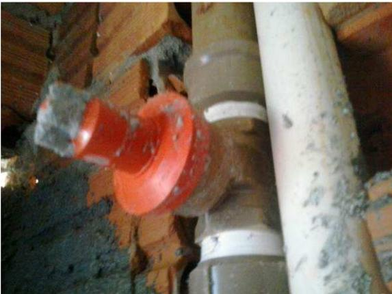
Figura 63C: Registro de gaveta de 1 1/2", instalado em wc PNE
