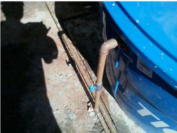
Figura 55C: Registro de esfera Em PVC 3/4", localizado na tubulação de alimentação dos reservatórios
