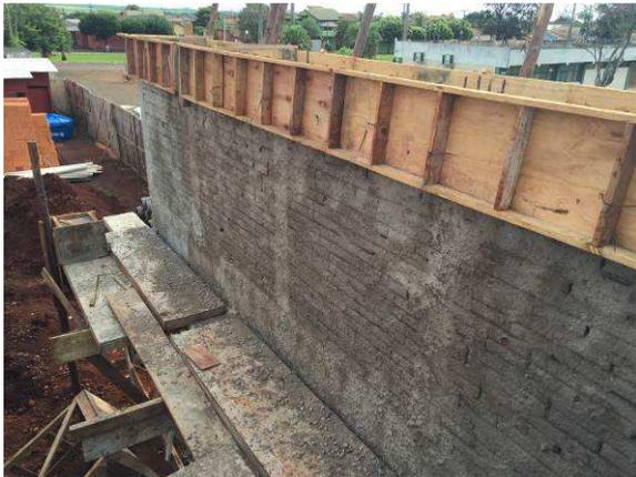
Figura 11C: Formas de vigas cintas e pilaretes de platibanda já concretados.
