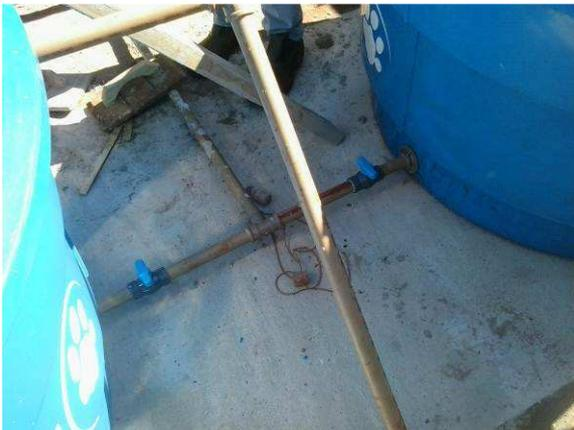
Figura 49C: No detalhe, dois registros de esfera de 1", instalados entre os reservatórios e a saída de alimentação da rede interna do imóvel
