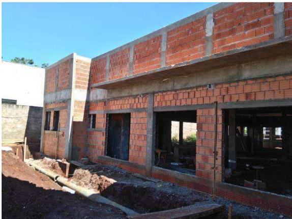
Figura 17C: No detalhe, alvenaria de fechamento externo da fachada leste, além do fechamento da platibanda. Na mesma imagem, vergas e contravergas das janelas localizadas nesta fachada
