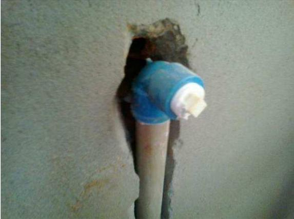
Figura 59C: Detalhe de ponto de água fria de 25mm
