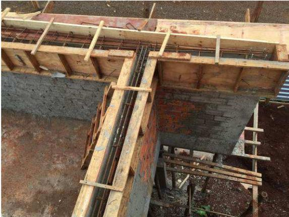
Figura 09C: No detalhe da imagem, formas e armaduras de vigas cinto de amarração da platibanda - fachada principal
