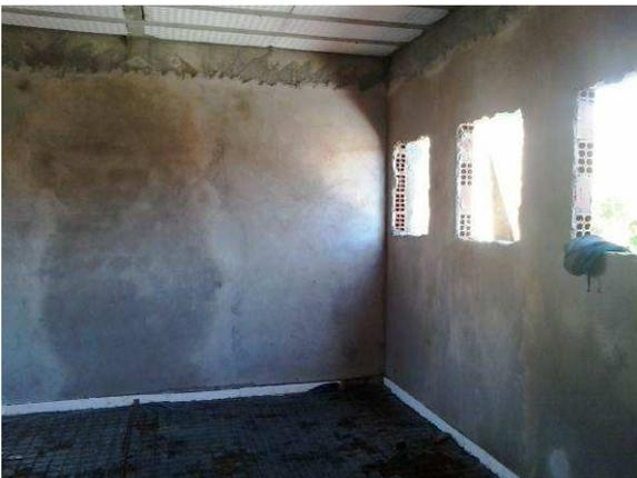
Figura 38C: Reboco realizado na face interna das paredes do arquivo
