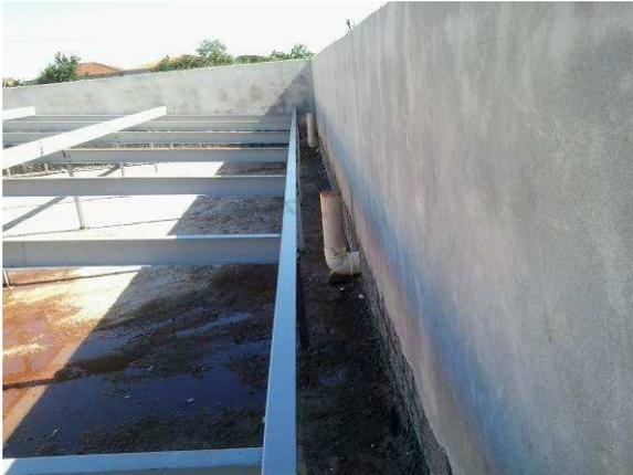
Figura 41C: Reboco já executado em face interna de platibandas, faces norte e oeste
