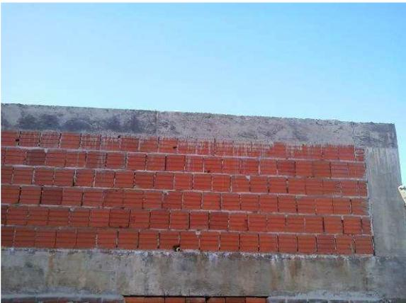
Figura 05C: No detalhe viga de coroamento sobre alvenaria do reservatório elevado
