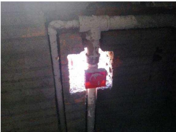
Figura 67C: Base para válvula de descarga instalada em bwc PNE da secretaria
