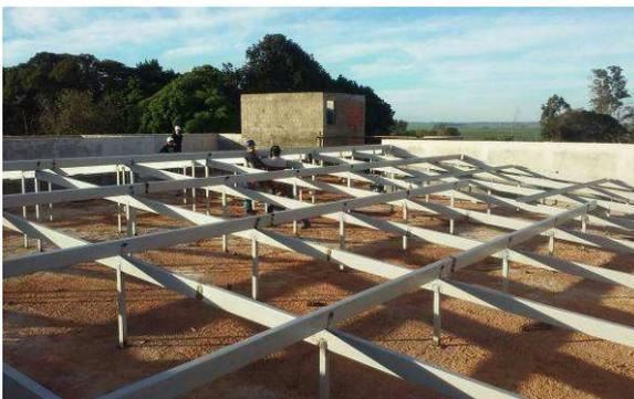
Figura 22C: Visão geral da cobertura - pontaletes, tesouras (vigas) e terças
