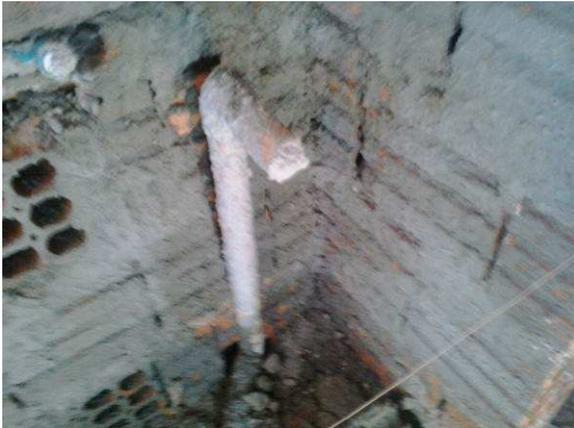
Figura 71C: Detalhe de ponto de esgoto secundário instalado em banheiro de juiz
