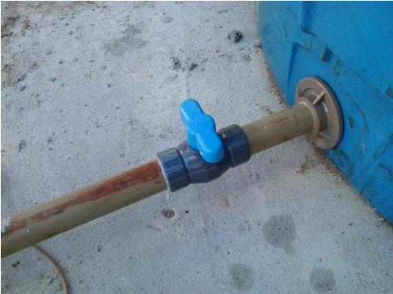
Figura 53C: Registro de esfera em PVC 2" , localizado na saída de limpeza de um dos reservatórios
