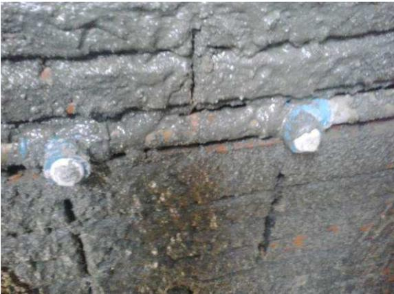
Figura 61C: Detalhe de pontos de água fria de 25mm
