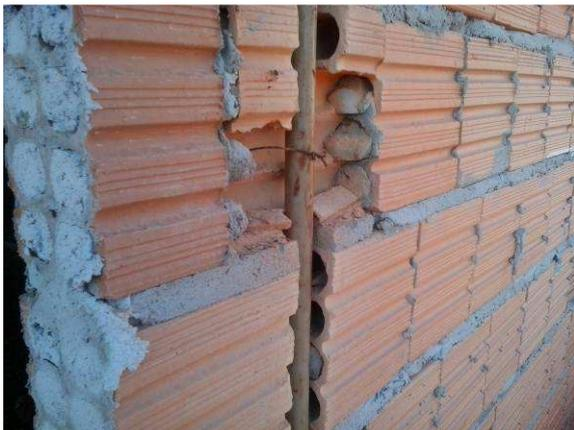
Figura 75C: Tubulação de dreno instalada
