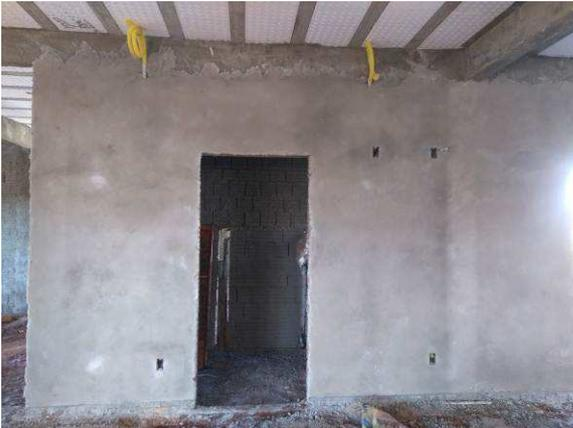
Figura 36C: Reboco realizado em parede da sala técnica
