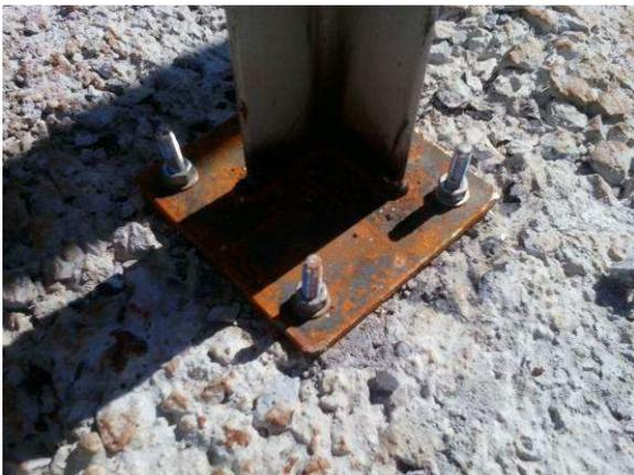
Figura 26C: No detalhe da imagem, a solda do pontalete a placa de base e a fixação da placa à laje através de parabolts
