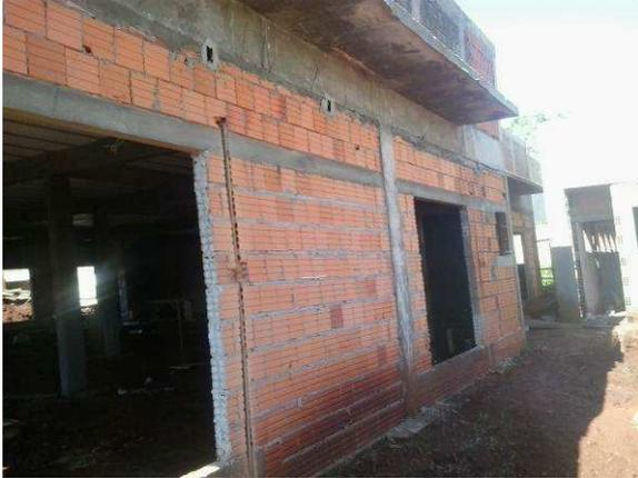
Figura 15C: Alvenaria de vedação executada na fachada oeste do imóvel principal
