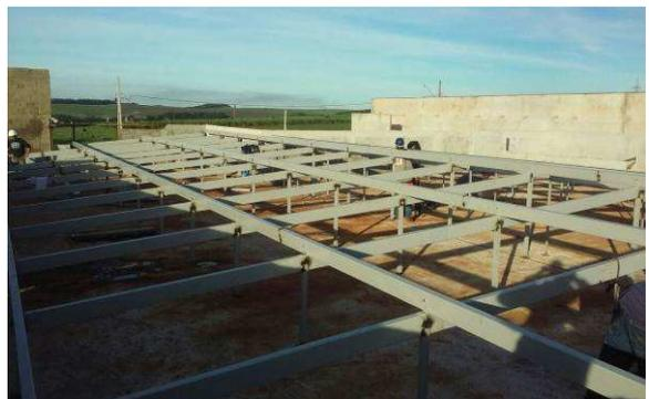
Figura 23C: Estrutura de cobertura, executado no imóvel principal
