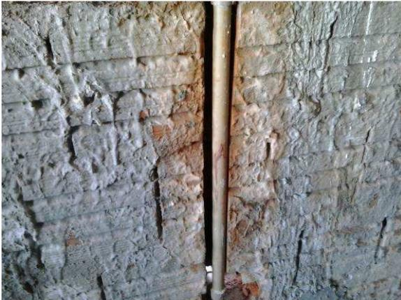
Figura 47C: Tubulação de água fria de 25mm, instalada em prumada da copa
