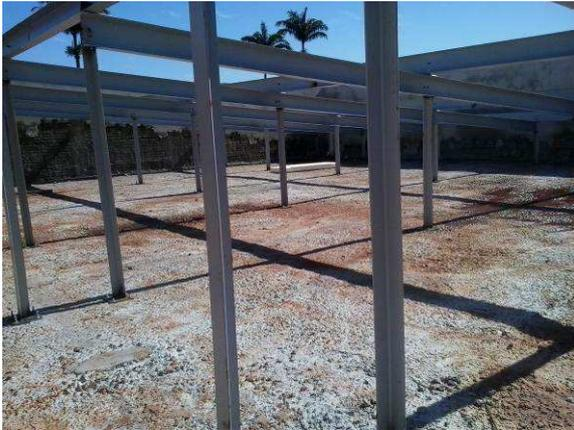
Figura 24C: No detalhe da imagem, os pontaletes fixados na laje e soldados nas vigas
