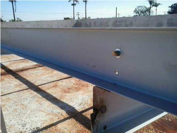
Figura 30C: Ligação entre terça e tesoura realizada através de parafuso
