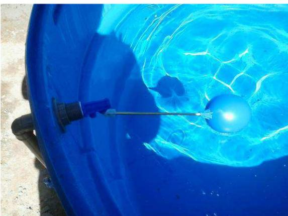
Figura 57C: Detalhe de reservatório com a bóia já instalada
