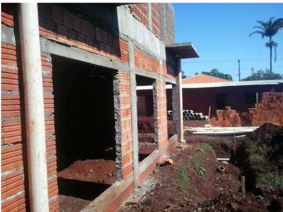
Figura 13C: Janelas localizadas na fachada frontal do imóvel, com suas vergas e contravergas já instaladas
