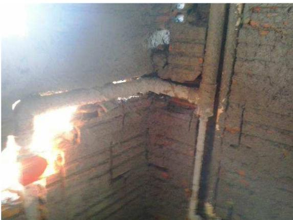
Figura 69C: Base para válvula de descarga instalada no bwc PNE público
