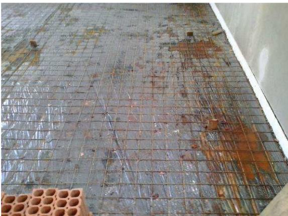
Figura 43C: No detalhe a aplicação da tela soldada no contrapiso do arquivo
