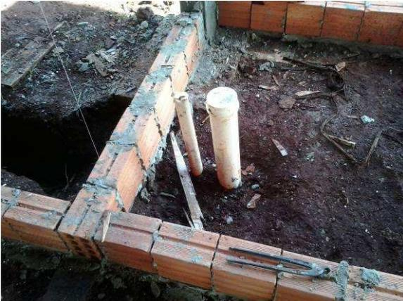
Figura 03C: Detalhe de ponto de esgoto executado, com vala já devidamente fechada
