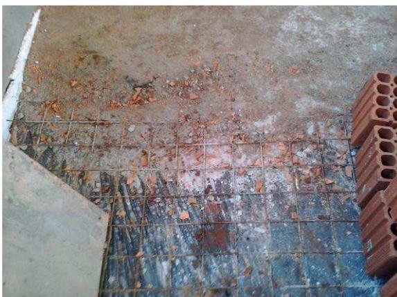
Figura 45C: Detalhe de trecho de transição - acima ponto já concretado e abaixo ponto com lona e tela, aguardando concretagem
