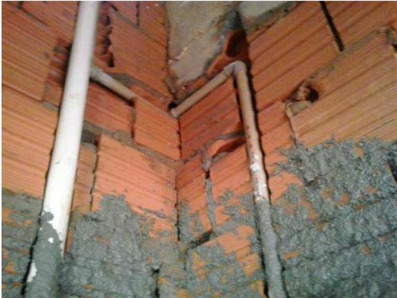
Figura 65C: Prumada de 50mm com um ramal de 25mm derivando
