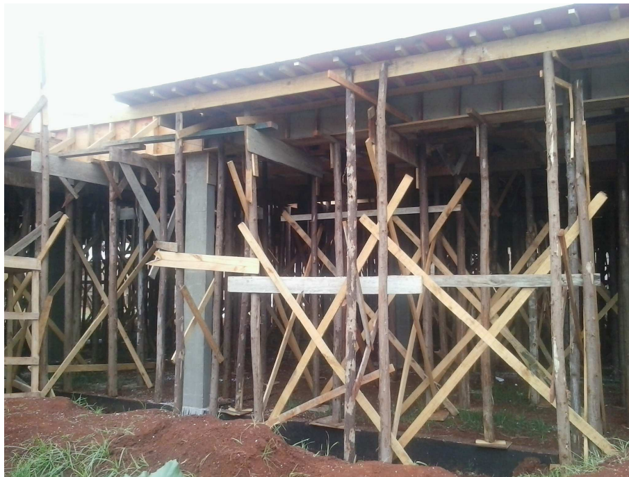
Figura 1 – Vista do canteiro de obras
