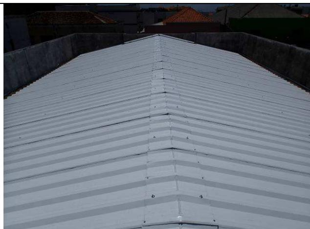
Figura 33C: Cobertura com telhas tipo sanduiche.
