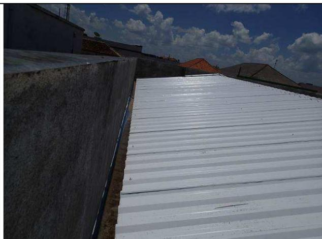
Figura 34C: Cobertura com telhas tipo sanduiche – linha de calha.
