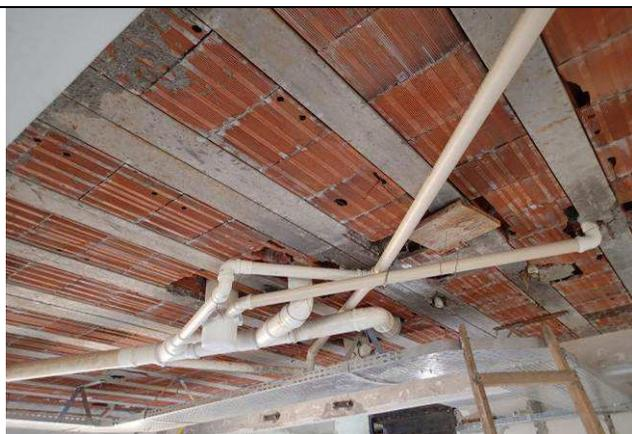
Figura 82C: Relocação de pontos de esgoto e instalação de caixas sifonadas.
