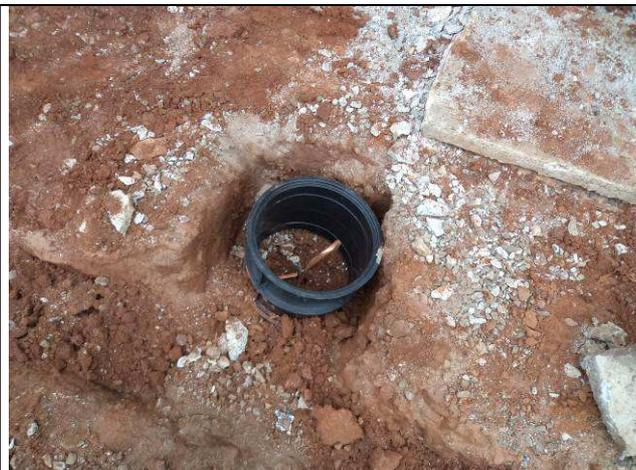
Figura 38E: Caixa de inspeção e hastes.
