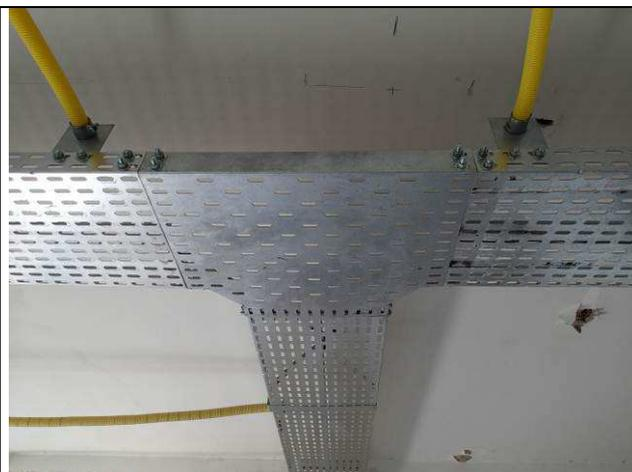
Figura 18E: Eletrocalhas e eletrodutos.
