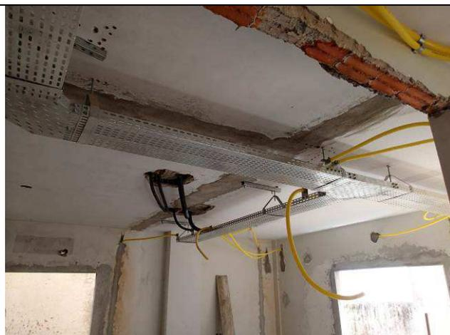
Figura 11E: Eletrocalhas e eletrodutos.
