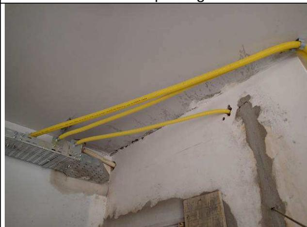
Figura 08E: Eletrocalhas e eletrodutos.
