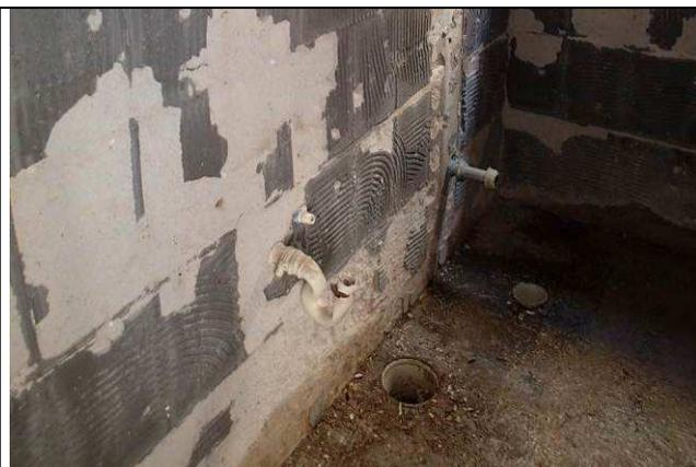
Figura 16C: Remoção de louças.
