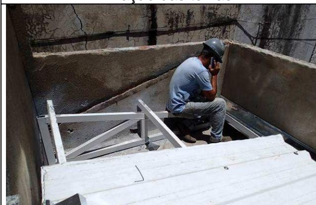
Figura 31C: Estrutura metálica de cobertura – anexo da laje do térreo.
