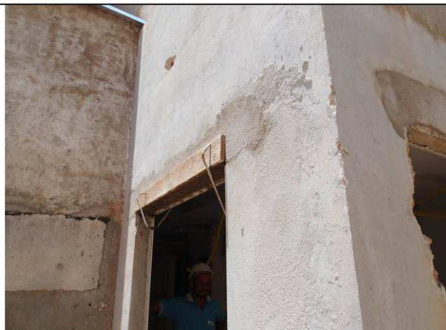
Figura 51C: Revestimento argamassado externo.
