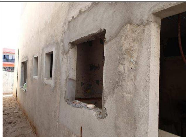
Figura 52C: Revestimento argamassado externo.
