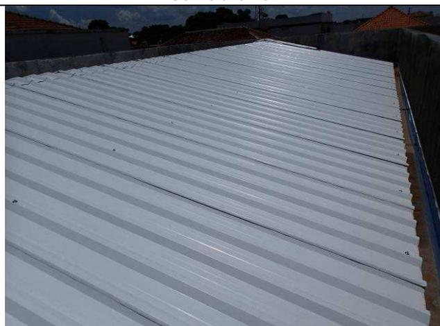
Figura 35C: Cobertura com telhas tipo sanduiche – linha de calha.
