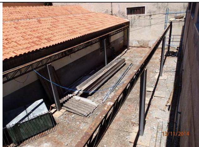
Figura 09C: Demolição da cobertura do estacionamento.
