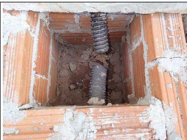
Figura 06E: Linha subterrânea em PEAD e caixas de passagem.
