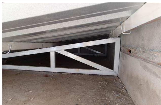
Figura 32C: Estrutura metálica de cobertura – anexo da laje do térreo.
