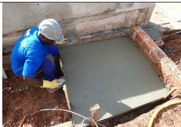
Figura 89C: Concretagem da rampa de acesso PNE.
