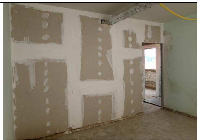
Figura 20C: Parede de gesso acartonado – gabinete do juiz.
