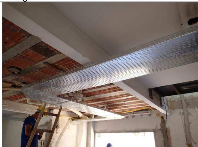
Figura 15E: Eletrocalhas e eletrodutos.
