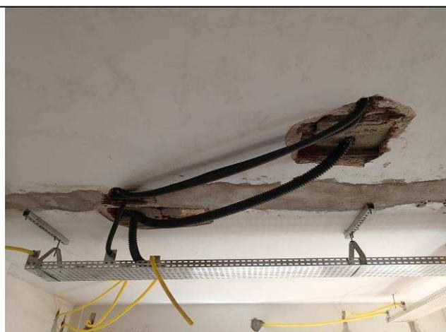
Figura 13E: Eletrocalhas e eletrodutos.
