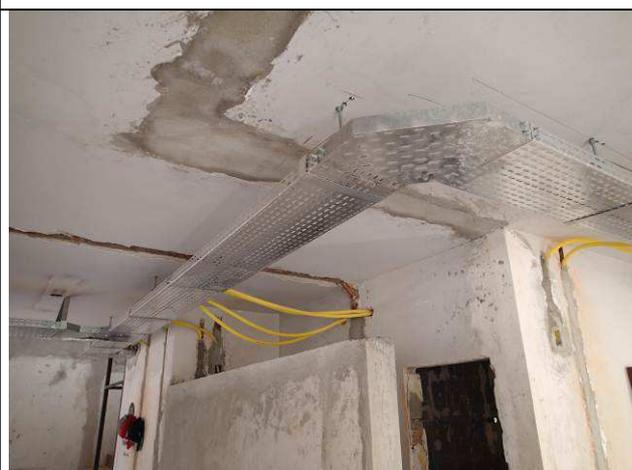
Figura 14E: Eletrocalhas e eletrodutos.
