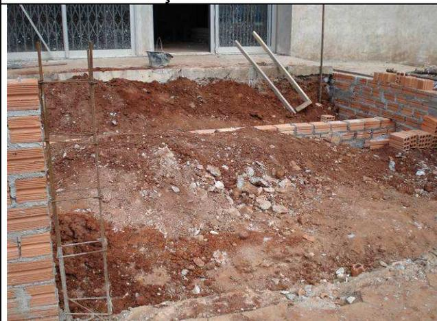
Figura 05C: Demolição do piso da entrada.
