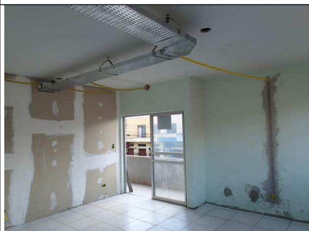
Figura 24E: Eletrocalhas e eletrodutos.
