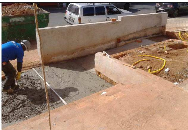
Figura 85C: Concretagem do acesso de pedestres.
