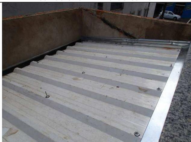
Figura 36C: Cobertura com telhas tipo sanduiche – anexo da laje do térreo.
