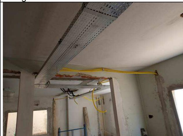
Figura 10E: Eletrocalhas e eletrodutos.
