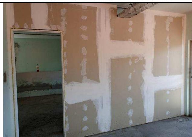
Figura 19C: Parede de gesso acartonado – sala de audiências.
