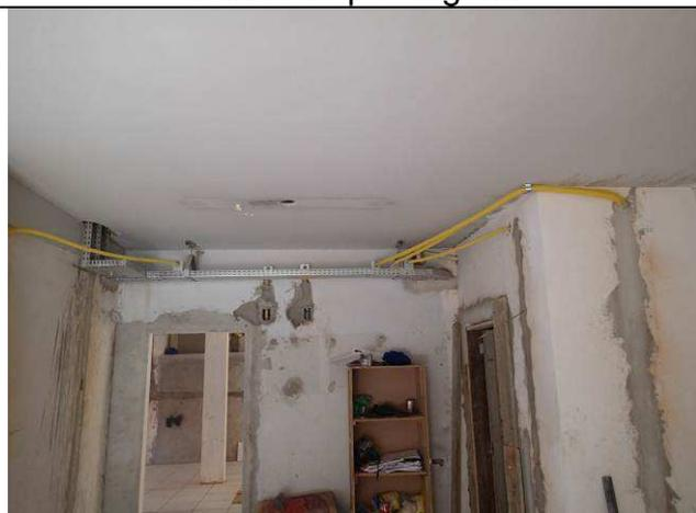
Figura 07E: Eletrocalhas e eletrodutos.
