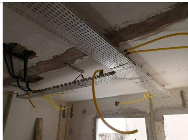
Figura 12E: Eletrocalhas e eletrodutos.
