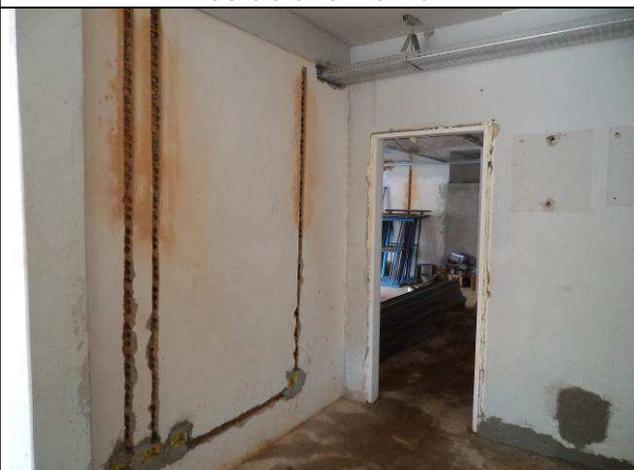
Figura 12C: Rasgos na alvenaria para passagem de eletrodutos.
