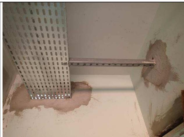
Figura 22E: Eletrocalhas e perfilado.
